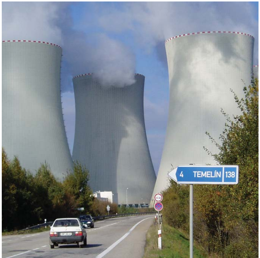
Zkušenosti MC-Bauchemie byly uplatněny i v rámci sanaci vnějších povrchů věží v jaderné elektrárně Temelín
