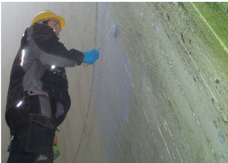
Momentka z aplikace druhé vrstvy (MC-DUR 2496 CTP) na mokrý povrch věže
