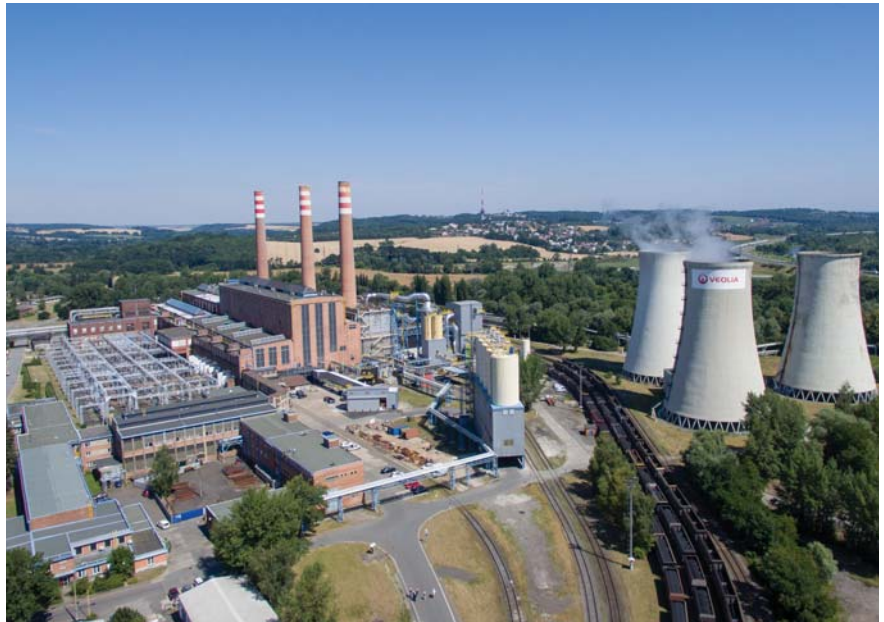
MC-Bauchemie realizovala i sanaci chladicích věží v Elektrárně Ostrava-Třebovice
