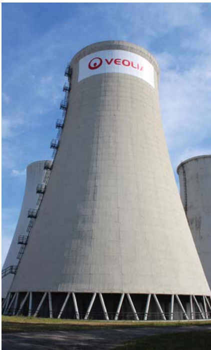
Dobrý stav ochladicí věže po 15. letech (ošetřeno nátěry MC-Bauchemie)
