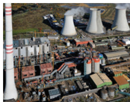
Obr. 6 – Pohled na budované zařízení
