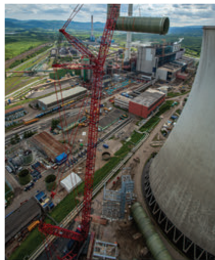
Obr. 5 – Montáž kouřovodů čistých spalin
