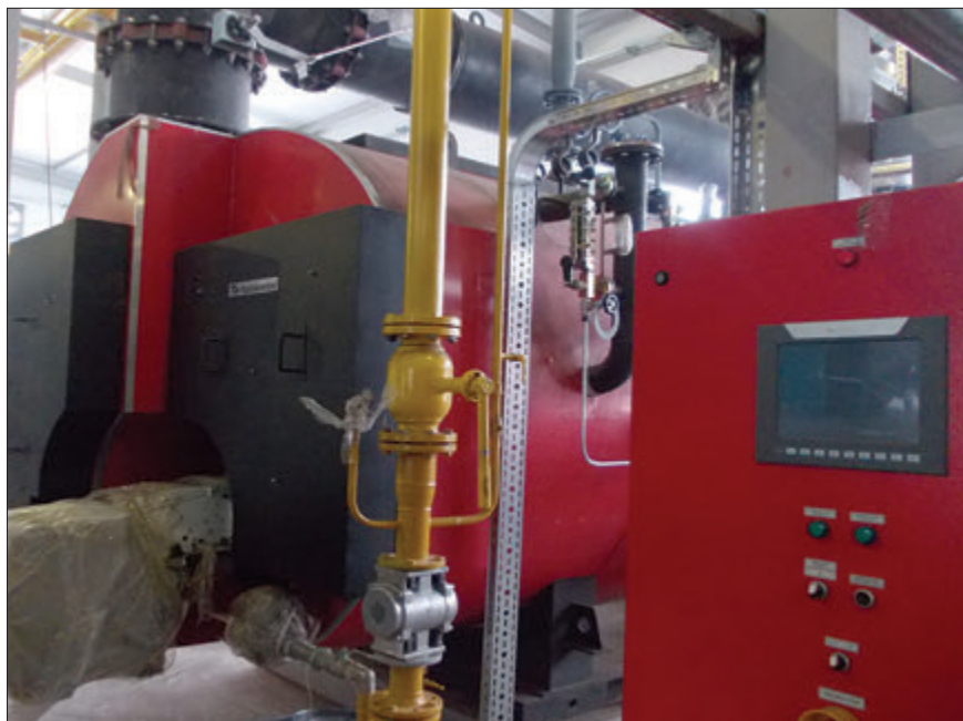
Kotel typu THS 25/7-KOMBI v průběhu instalace
