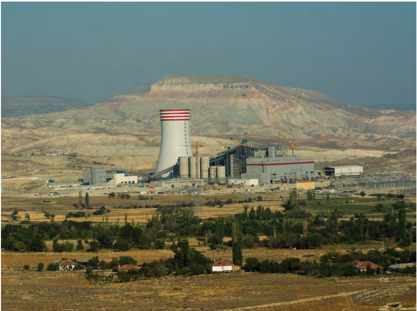
Pohled na tureckou elektrárnu Adularya ve výstavbě - ilustrační foto
