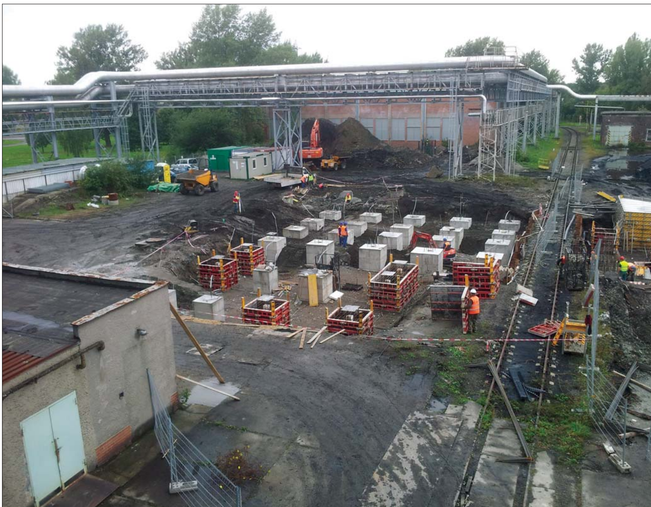
Pilotové pole budoucí stavby odsíření
