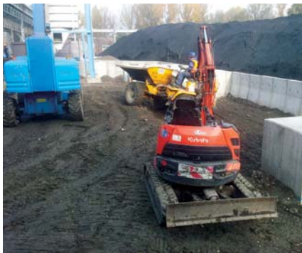
Realizace nové opěrné zdi pro sklad paliva
