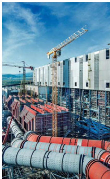
Investiční celek Elektrárna Pruněv II v rekonstrukci – ilustrační foto
