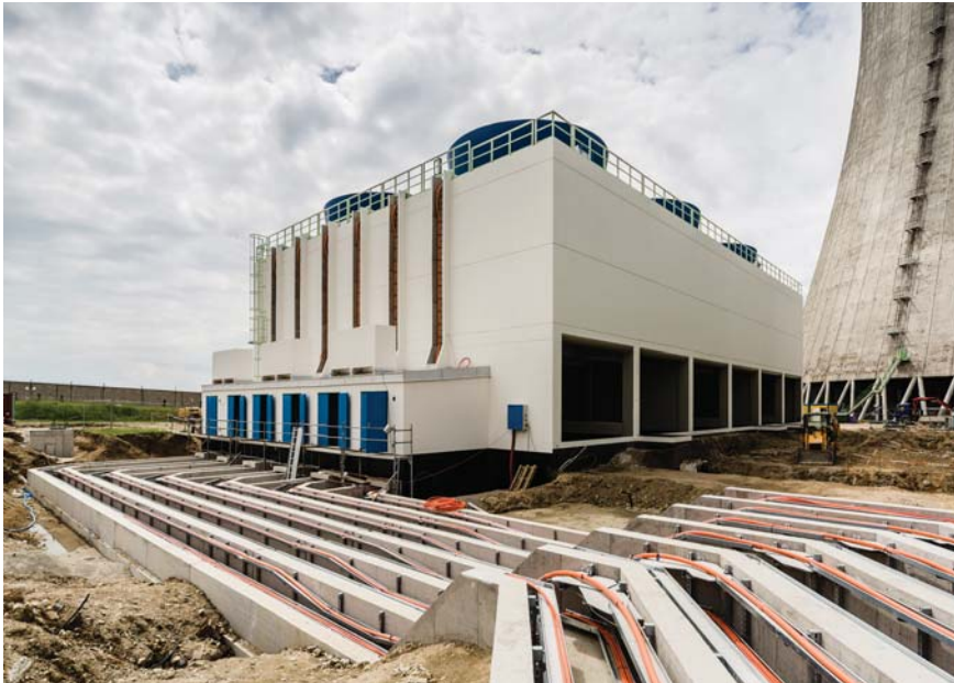
Pohled na realizaci KJT
