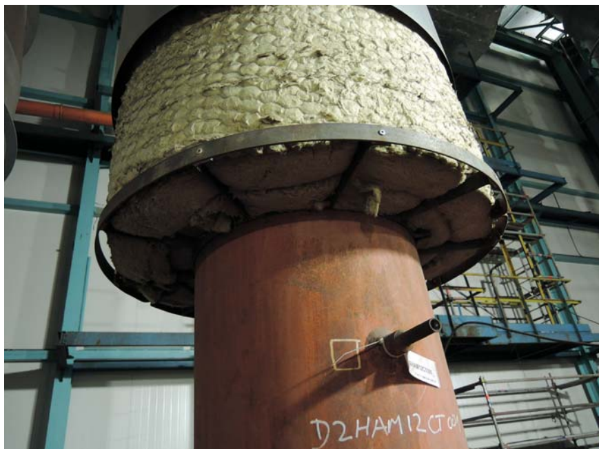
Obr. 3 – Potrubí páry k bifluxu, dokončování izolace
