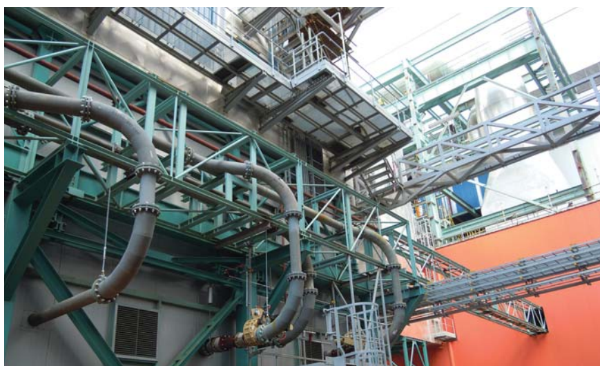
Obr. 5 – Popílkovody vybrané pro inspekce RIMaSys, sledování vlivu abrazie
