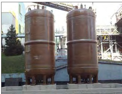
Nadzemní sklolaminátové vertikální nádrže DN 3000, objem 46 m 3 (ALSTOM, s.r.o.)
