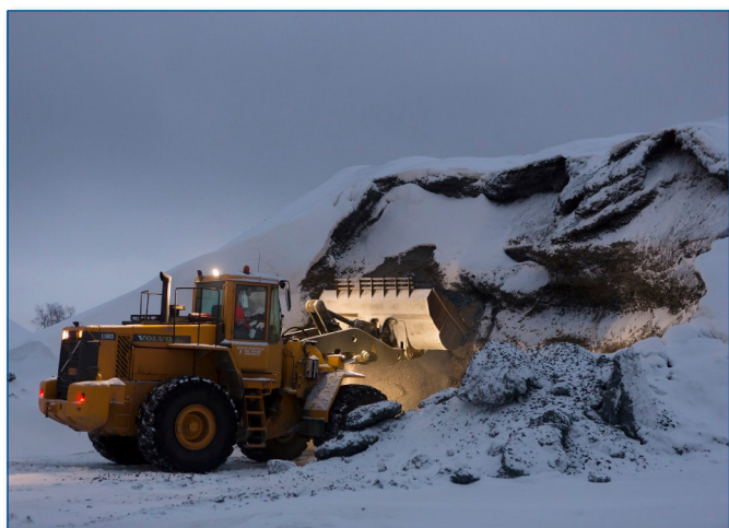
Přípravné práce – budování cesty na poloostrov Hanhikivi, leden 2015.
