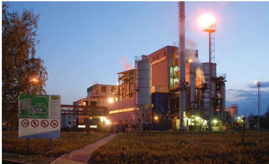
SITA CZ ročně získá z odpadu 71 600 GJ využitelného tepla (údaj za rok 2013). Na fotografii Spalovna průmyslových odpadů SITA CZ v Ostravě.
