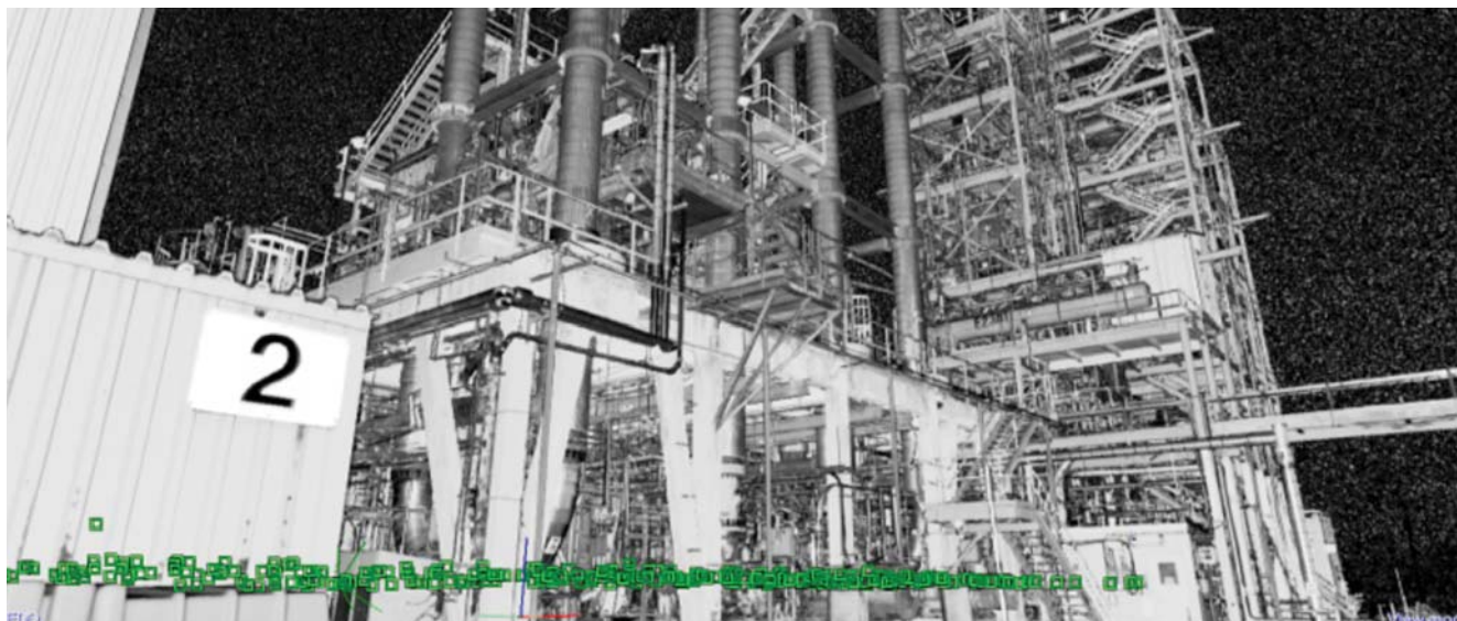
Pohľad na jeden z tisícky laserových skenov polymerizačnej stanice, pomocou ktorých sme vytvorili jej inteligentný 3D CAD model
