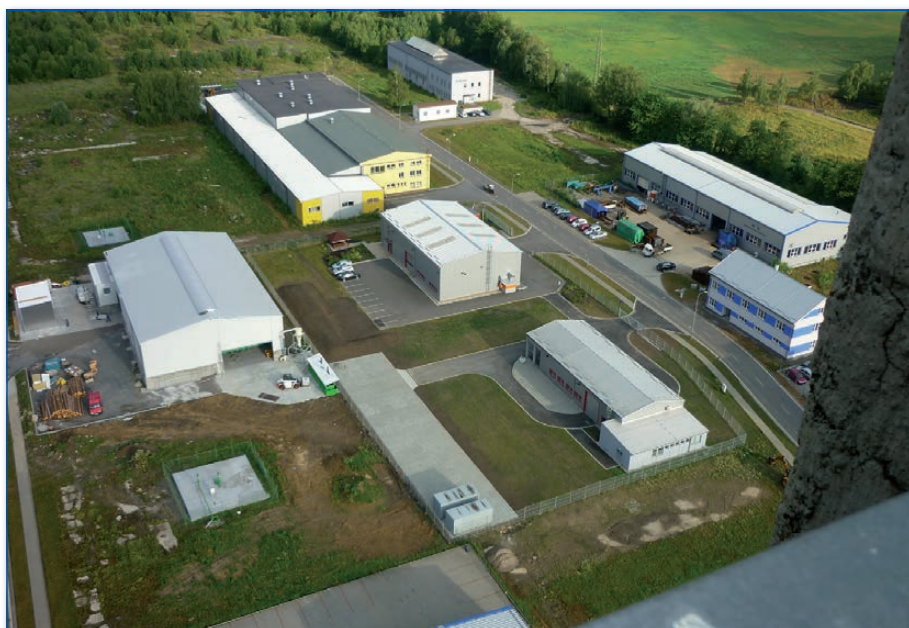
Po likvidaci povrchových objektů vznikla průmyslová zóna, stav 2014
