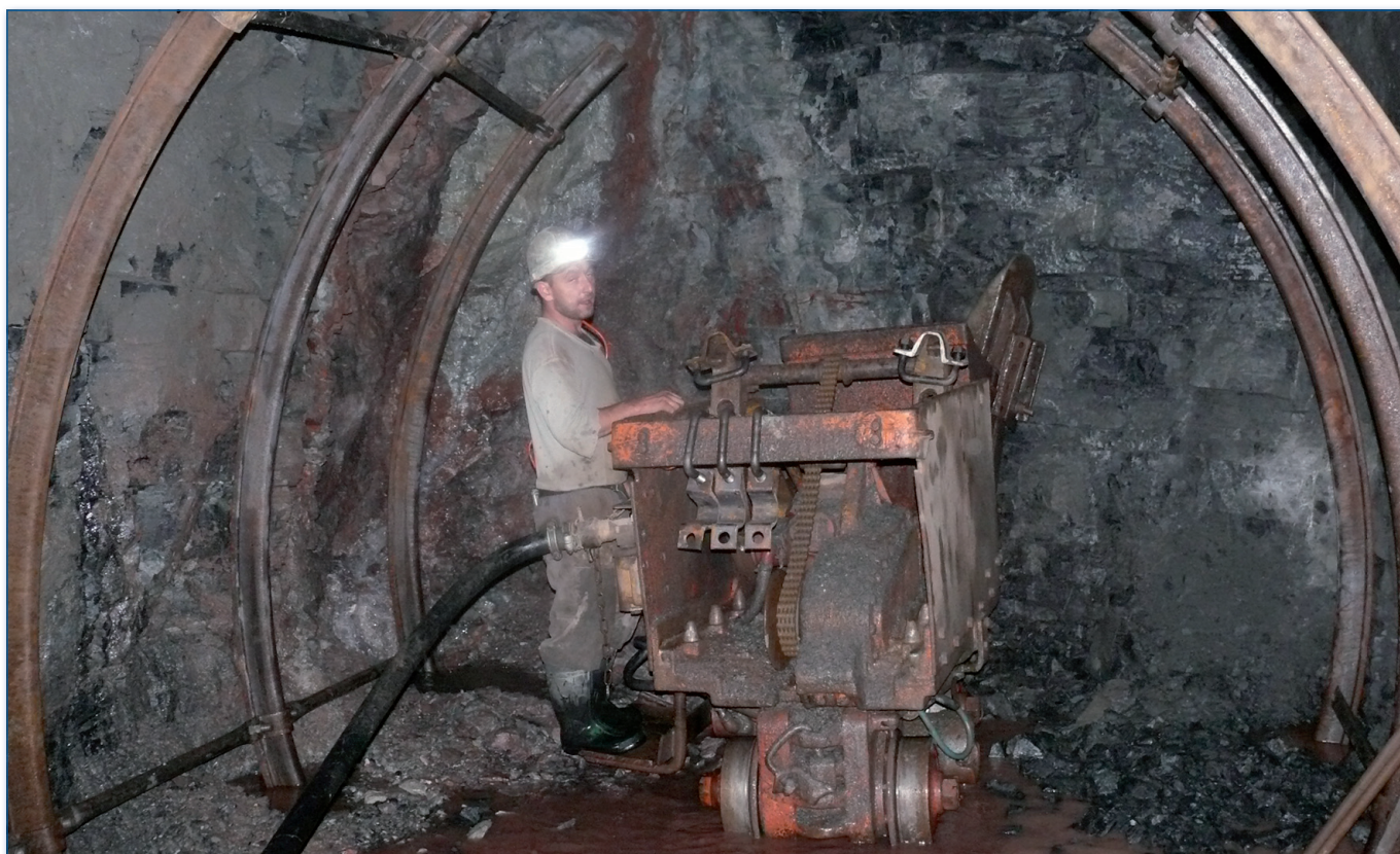
Ražba průzkumného překopu
