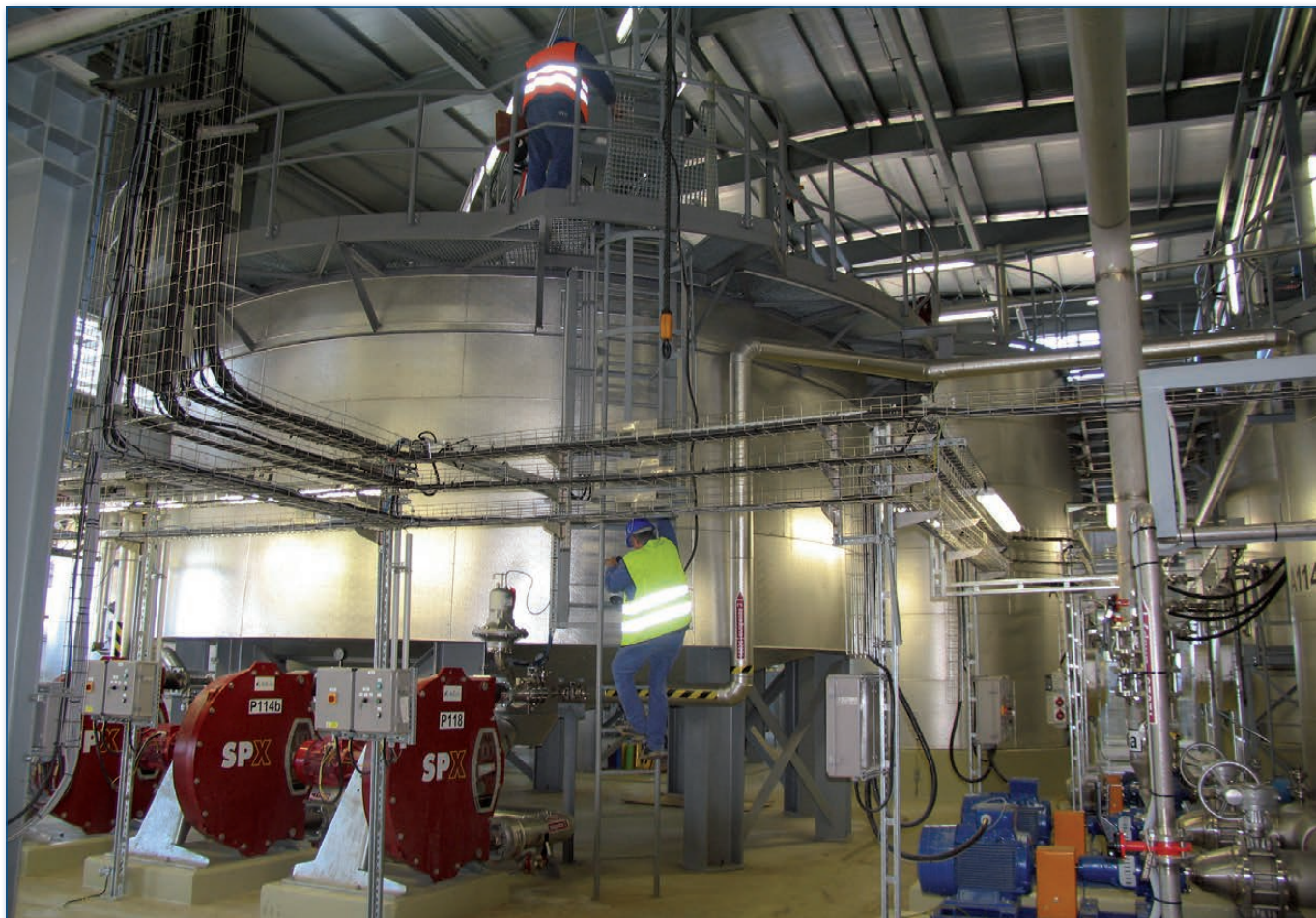
Technologie NDS ML zahušťování suspenze v Dorrově usazovák
