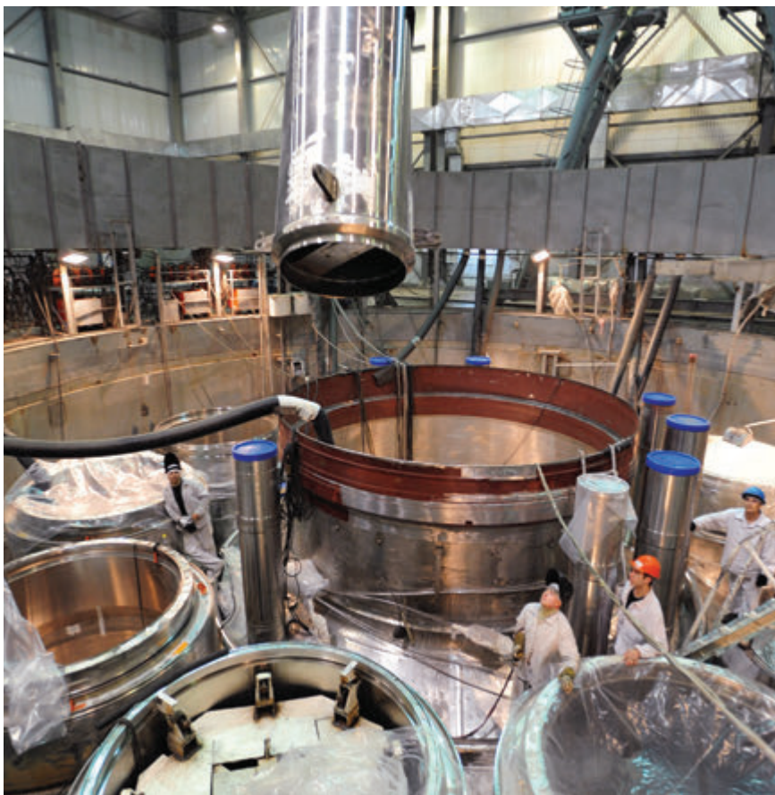
Montáž jednotlivých zařízení primárního okruhu, které se nacházejí v bazénu obklopujícím reaktorovou nádobu
