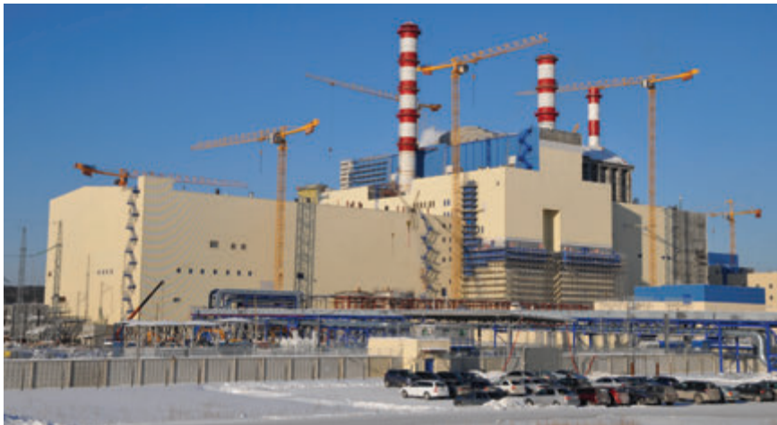
Dokončování stavby provozních budov 4. bloku Bělojarské jaderné elektrárny
