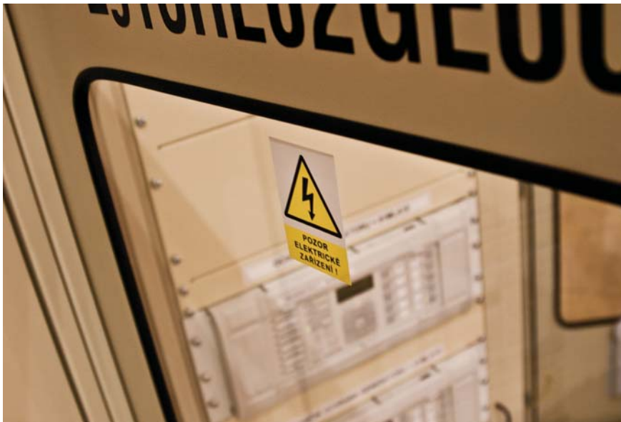
Rekonstrukce systému chránění přečerpávací elektrárny – ilustrační foto
