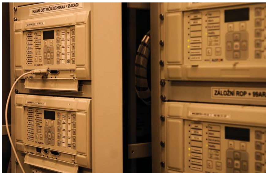
Hlavní distanční ochrana
