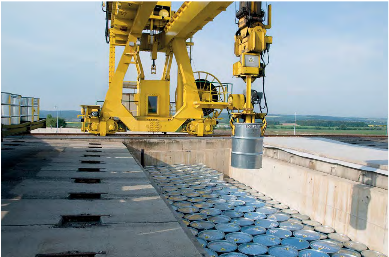
Úložiště radioaktivních odpadů v Dukovanech
