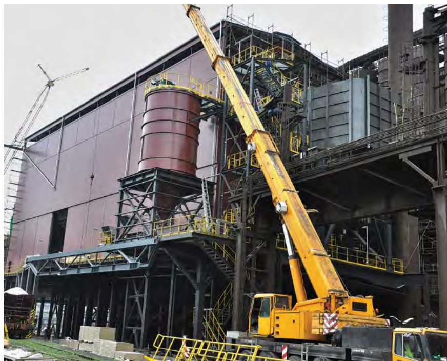
Pohled na objekt sekundárního odprášení ocelárny v Třinci
