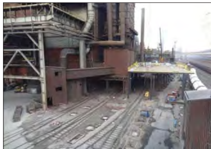
Snímky z montáže ocelové konstrukce hlavní budovy sekundárního odprášení. Jsou patrné stísněné prostory a bezprostřední blízkost železničních kolejí
