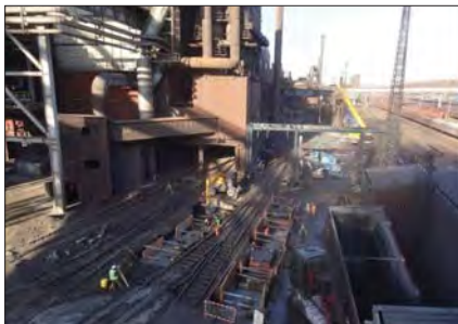
Snímky z montáže ocelové konstrukce hlavní budovy sekundárního odprášení. Jsou patrné stísněné prostory a bezprostřední blízkost železničních kolejí
