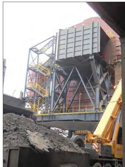
Místo, kde dojde k napojení přívodního potrubí do filtrační stanice
