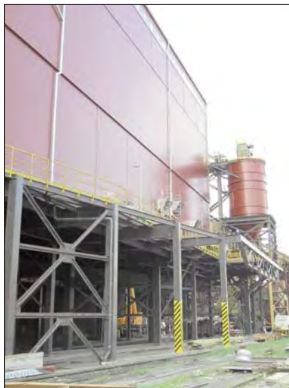
Pohled na budovu filtrační stanice + silo
