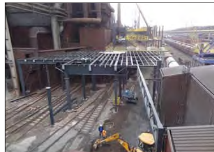
Snímky z montáže ocelové konstrukce hlavní budovy sekundárního odprášení. Jsou patrné stísněné prostory a bezprostřední blízkost železničních kolejí
