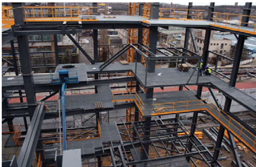
Postup montáže (úroveň +27 metrů)
