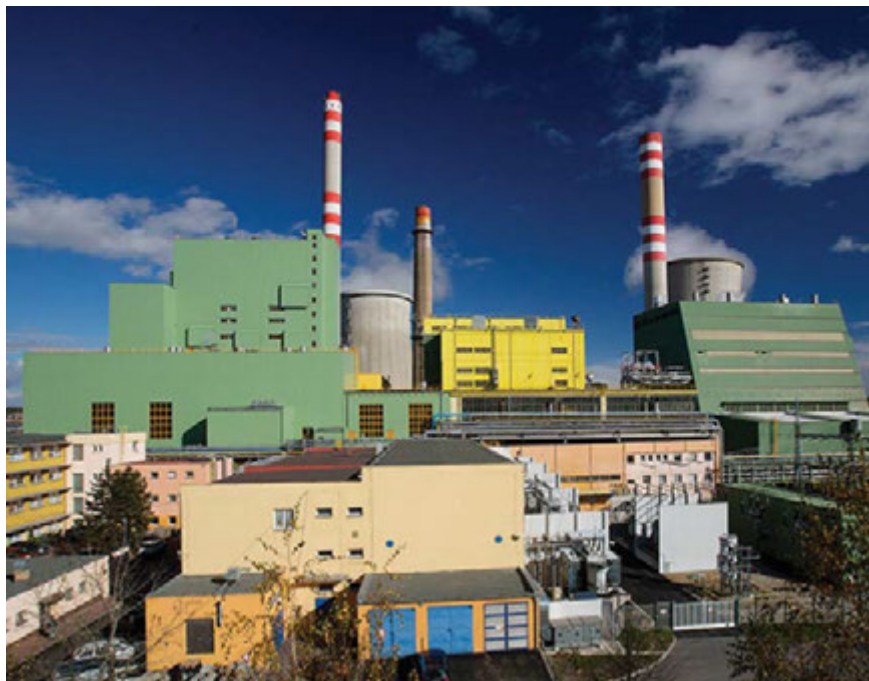
Pohled na Elektrárnu Kladno, nový blok K7
