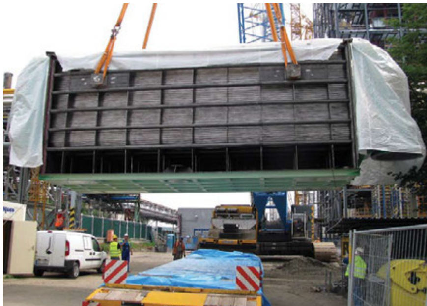
Zavážení kondenzátoru na elektrárně
