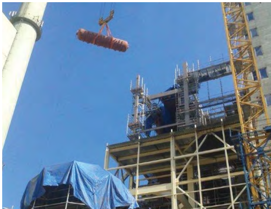
Snímek z výstavby nového kotle v Energetice Třinec
