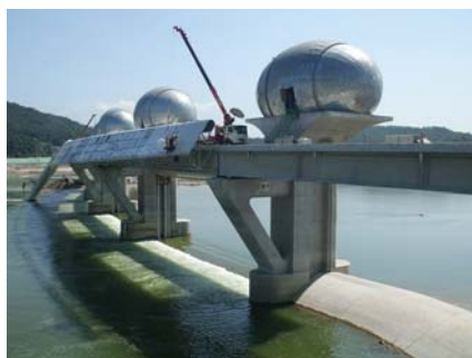
Vodní elektrárna (Jižní Korea, Yipo)
