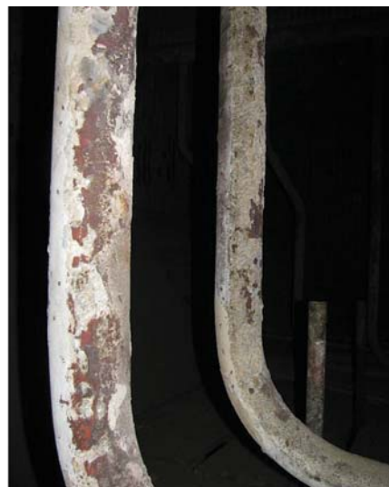
Obr. 4 – Porovnání zanesení trubek výparníku před a po odstávce a údržbě (říjen 2014)
