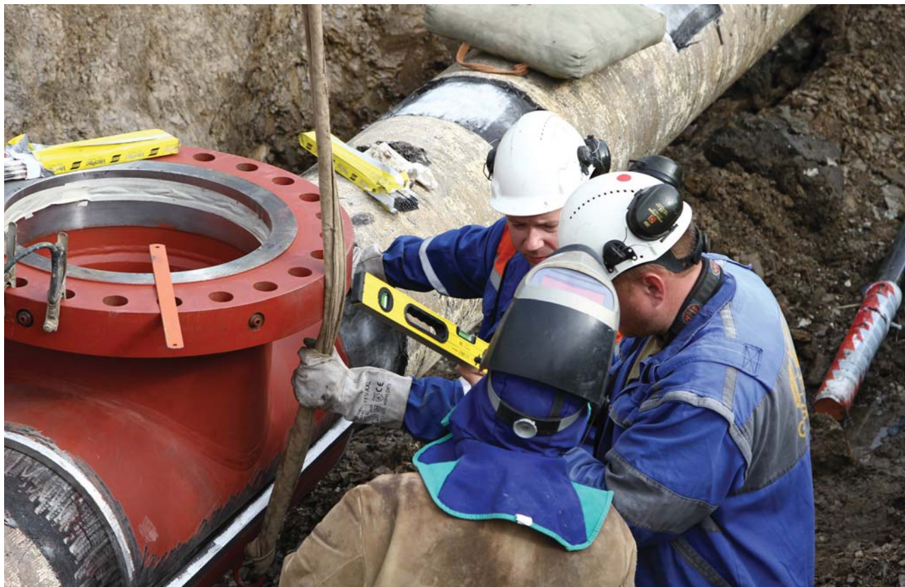
Snímek z montáže plynového potrubí v Žukově (Moravskoslezský kraj)
