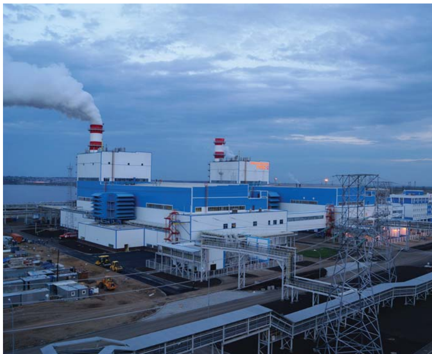
Dva nové bloky Južnouralské tepelné elektrárny byly díky Multi-D postaveny v o pětinu kratším čase
