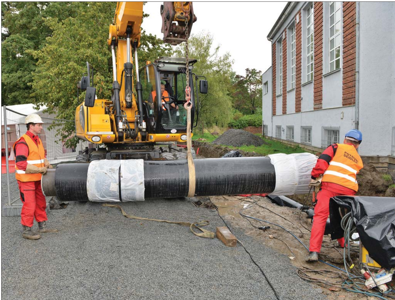
Letos teplárny modernizovaly více než 18 kilometrů rozvodů tepla - ilustrační foto
