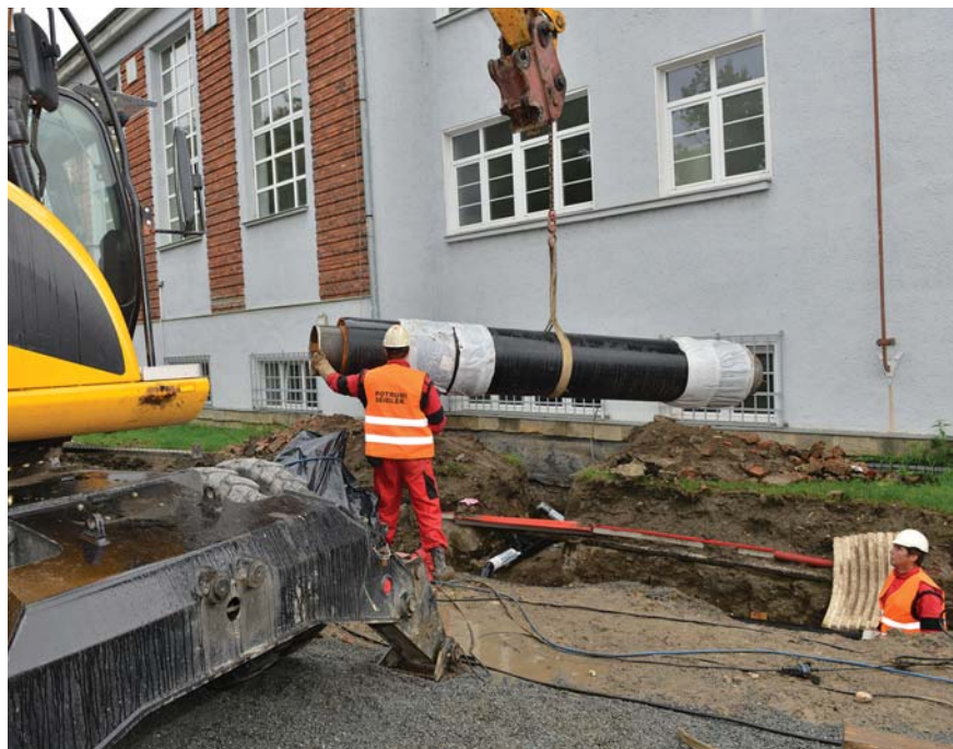
Snímek z rekonstrukce rozvodů tepla v Olomouci (Dalkia ČR) - ilustrační foto
