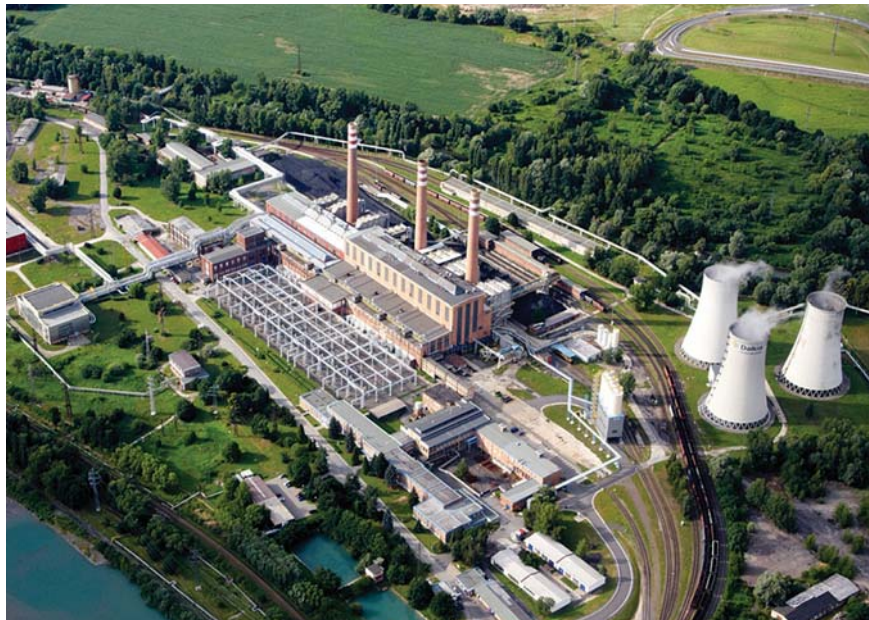
Zdroj dálkového vytápění tepla v Ostravě-Třebovicích
