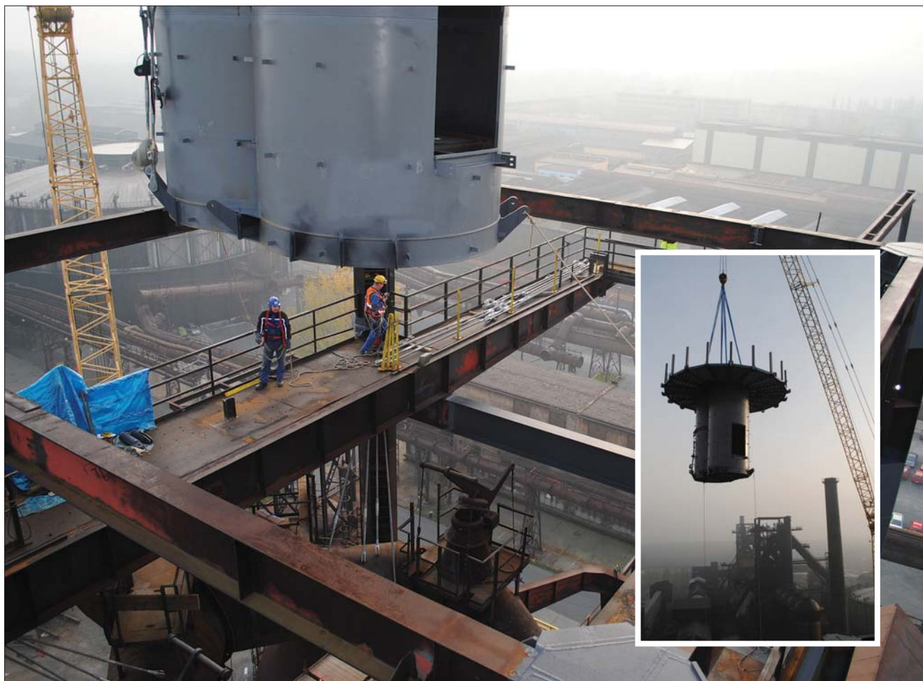
V Dolní oblasti Vítkovic se stále něco děje – na snímku instalace prvního ze tří modulů na samotný vrchol vysoké pece. Několik desítek tun oceli a skla vytvoří unikátní vyhlídkovou věž s expozicí
