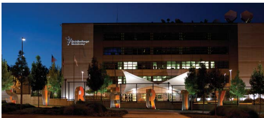
Rádio Svobodná Evropa - dodávka elektrotechnických systémů. Dodávka a montáž komplexních řešení silnoproudých a slaboproudých elektrotechnických systémů včetně jejich realizační dokumentace podle nejpřísnějších standardů vlády USA
