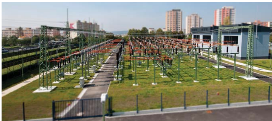
Praha Lhotka - obnova TR 110/22 kV. Během dvou let byly za provozu zcela zrekonstruovány všechny úrovně napětí - VVN, VN a NN
