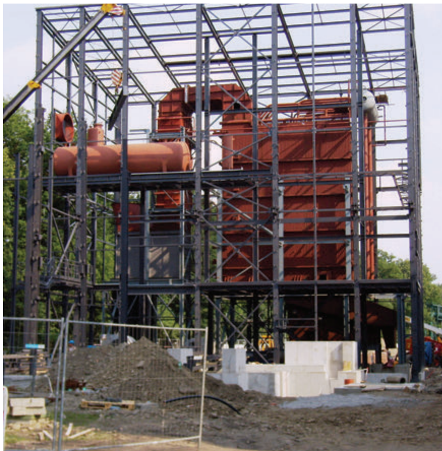
Stav montáže kotelny k 4. 7. 2012
