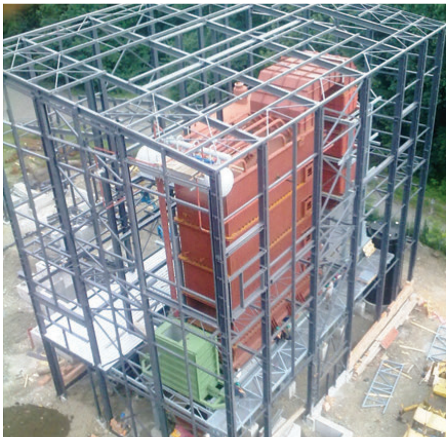
Stav montáže kotelny k 4. 7. 2012
