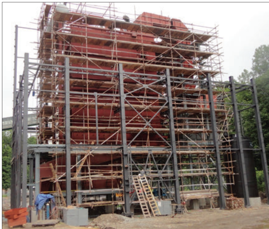
Stav montáže kotelny k 18. 6. 2012
