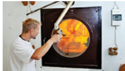
Na snímku tzv. horká komora (HK), kobka z těžkého betonu – tloušťka stěn je 60 cm - určená k bezpečné práci s vysoce radioaktivními materiály. V čelní stěně kobek jsou průzory z olovnatého skla. Konstrukce a vybavení HK umožňuje provádět po-radiační zpracování ozářených pouzder ze vzorky a demontáž vzorků ze sond a vestaveb vodních smyček, případně opravy a úpravy na těchto zařízeních. Stínící vlastnosti HK zabezpečují bezpečné hodnoty radiačního pole pro pracovníky ve všech obslužných prostorech. (foto archiv ÚJV Řež, a. s.)
