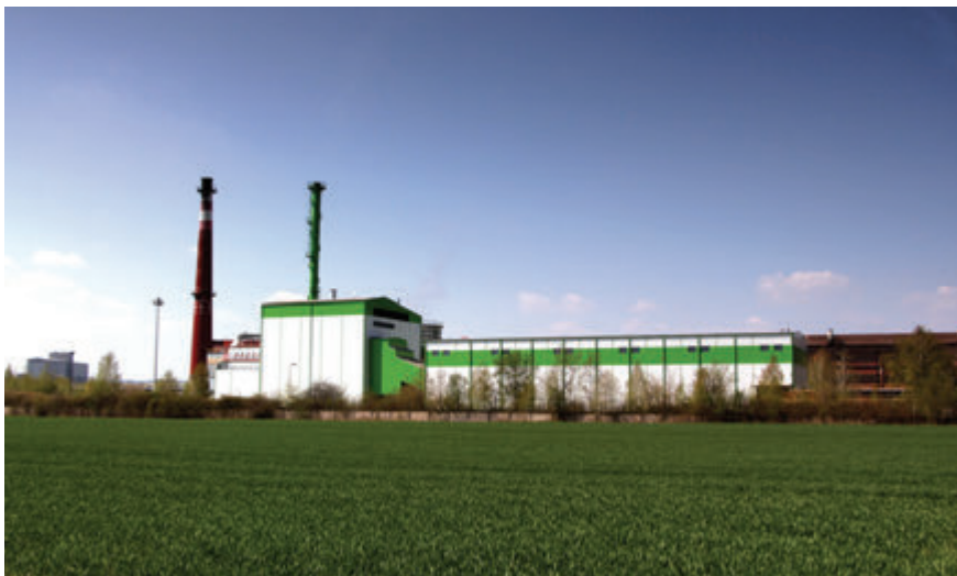
Celkový pohled na elektrárnu v Kutné Hoře
