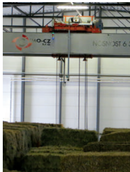
Pohled do skladu paliva
