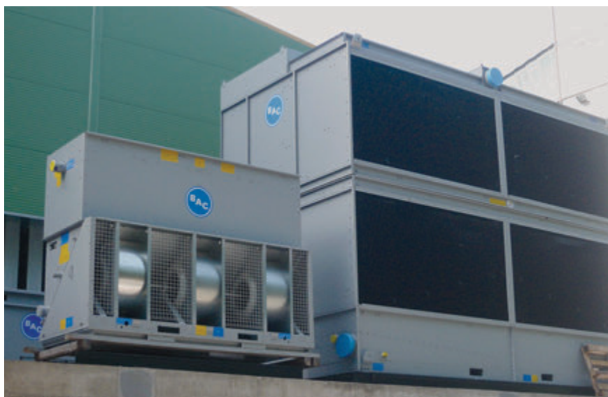
Obr. 15 – Chladicí věže
