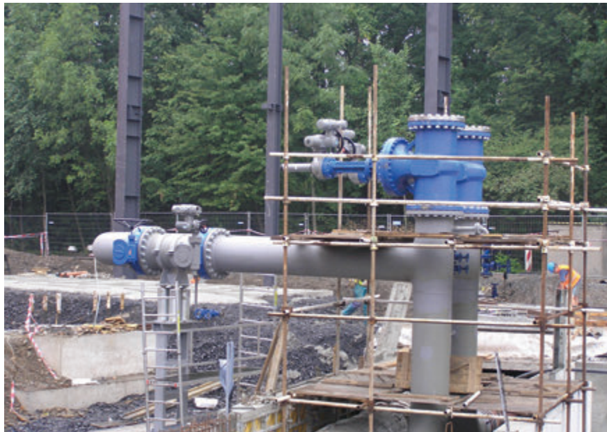
Obr. 9 – napojení bioelektrárny na stávající horkovod
