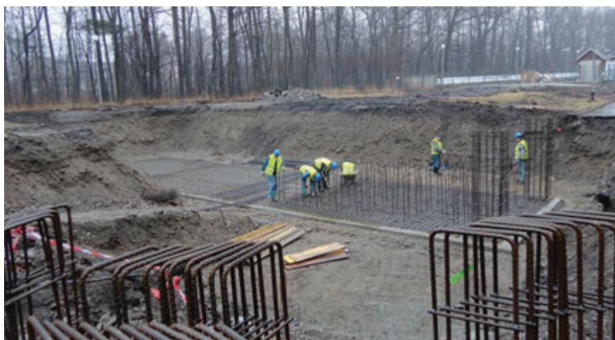
Obr. 7 – Armování základů kotle
