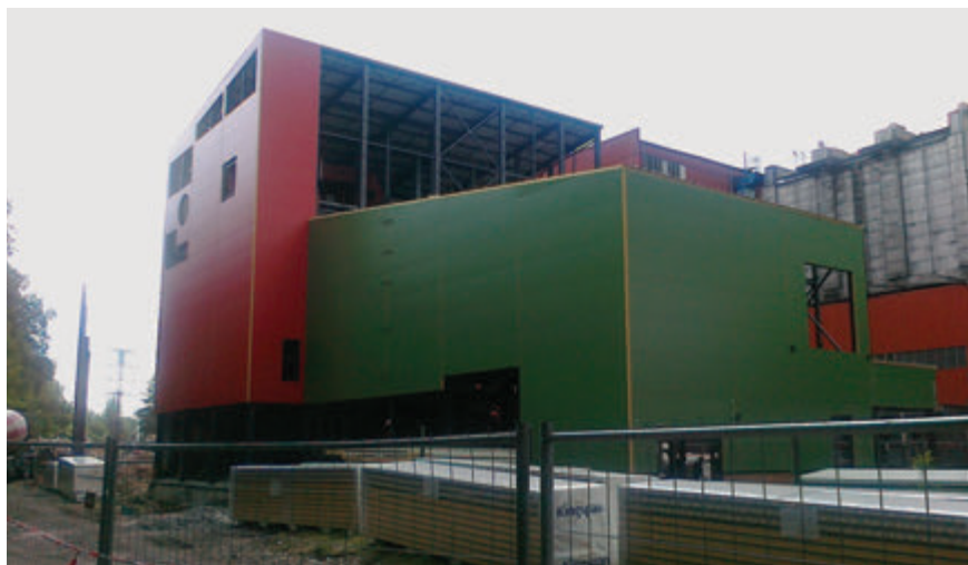
Obr. 8 – Průběh opláštění hlavních objektů
