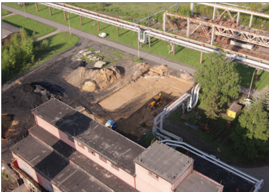
Ekologizace výtopny 2 - Skrývka pro výstavbu nové haly paliva
