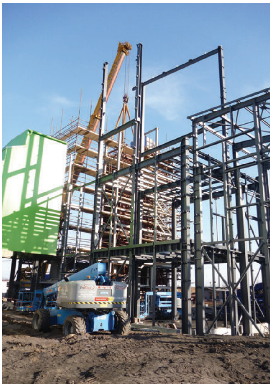
Pohled na rozestavěnou tepelnou a turbinovou strojovnu
