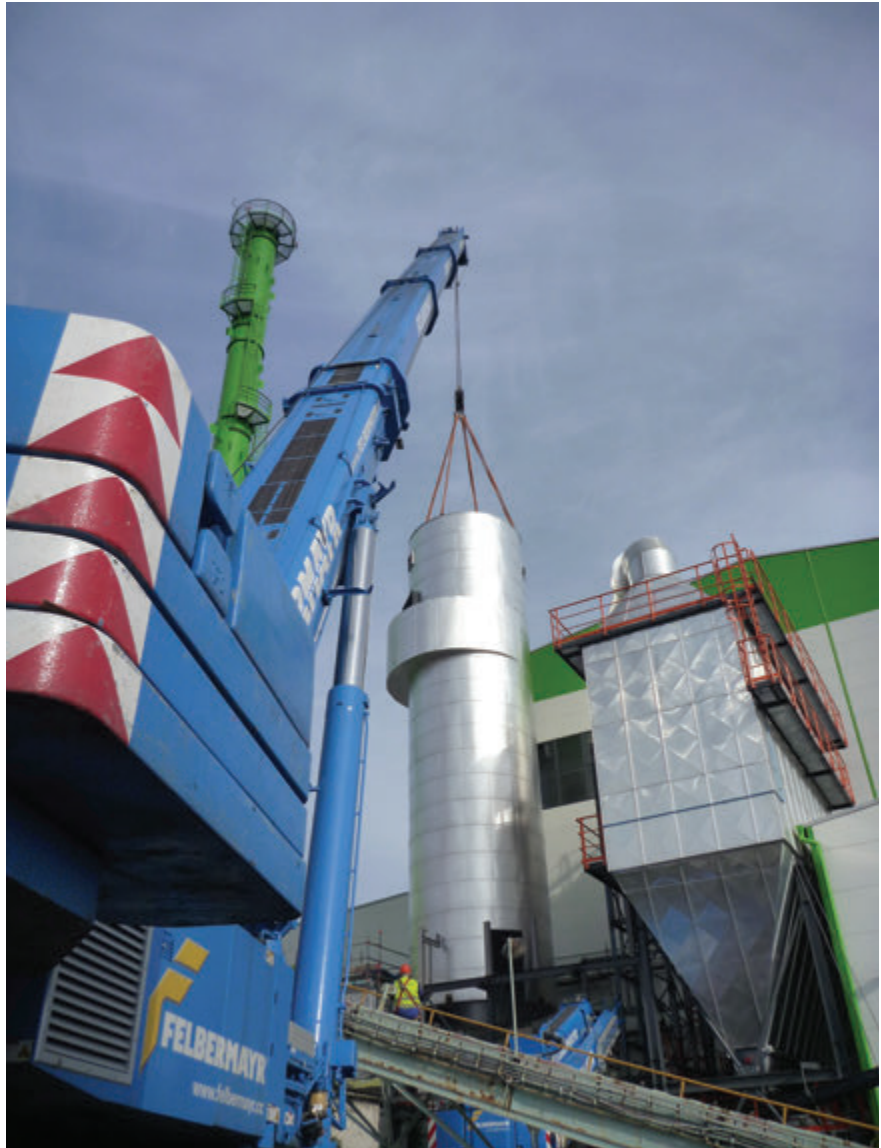
Instalace nového filtru
