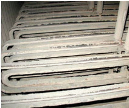
Obr. 15 – Trubkovnice přehříváku Zvolenské teplárenské, a. s. po 8 týdnech provozu
