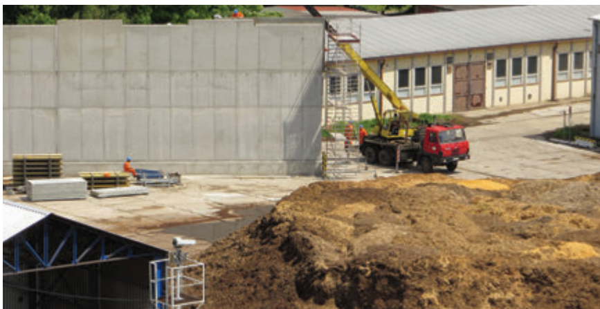
Skladování biomasy. Vzadu výstavba protihlukových zdí
