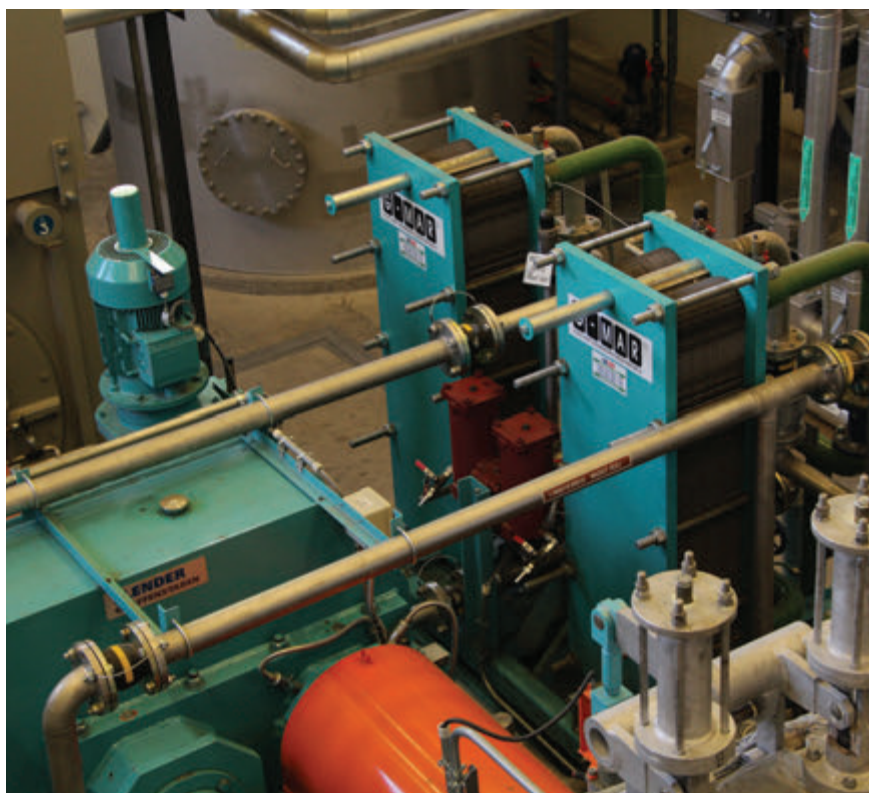
Deskové výměníky olejového chladiče turbosetu
