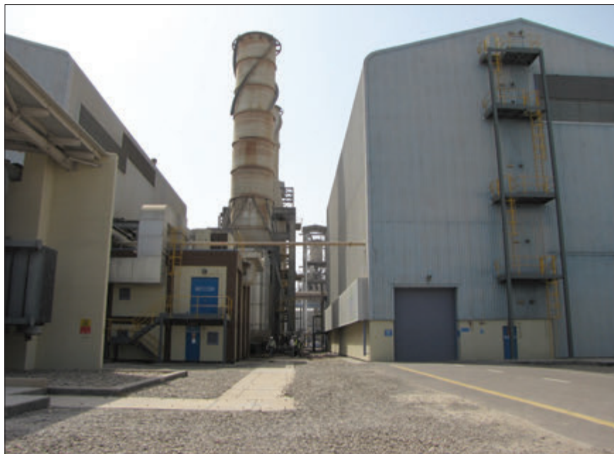
Původní kotle před výměnou
