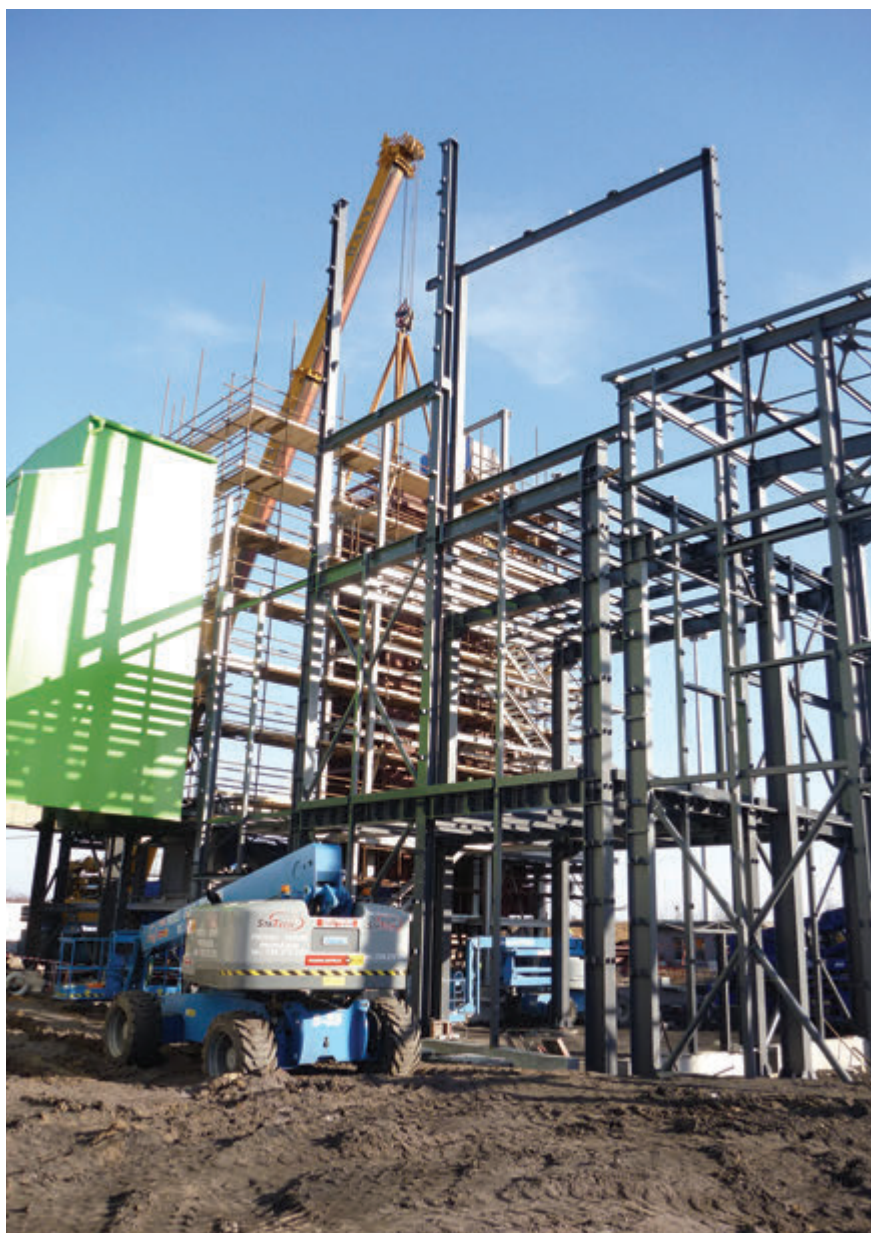
Pohled na rozestavěnou tepelnou a turbinovou strojovnu
