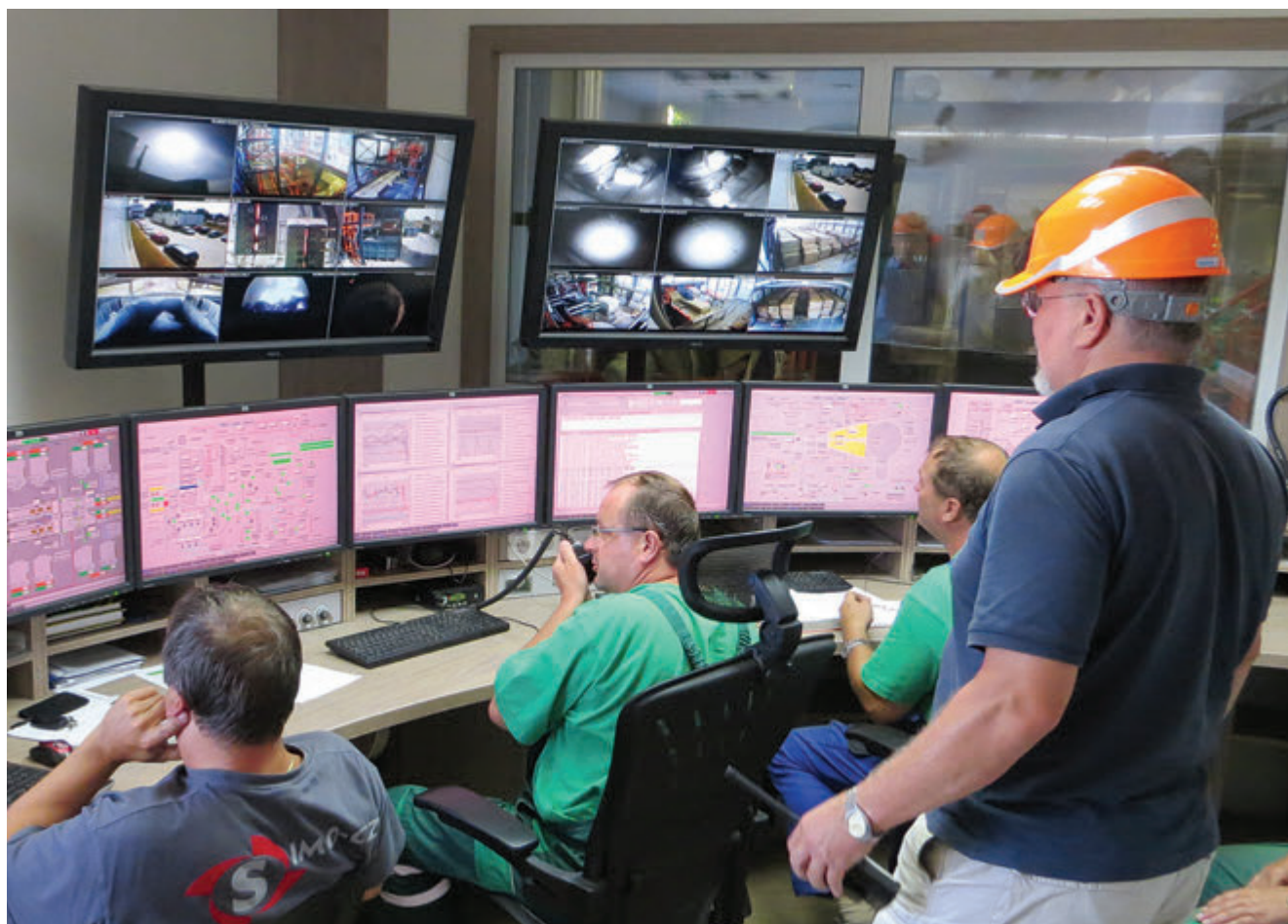
Snímek z velínu při uvádění do provozu
