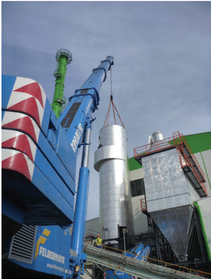
Instalace nového filtru
