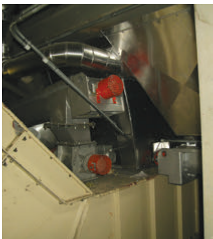
Doprava popílku ze čtvrtého tahu do mokrého vynašeče
