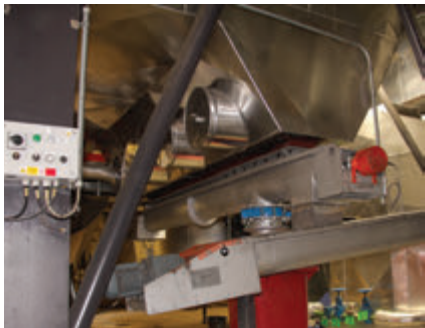
Soustava šneků pro vynášení popílku
