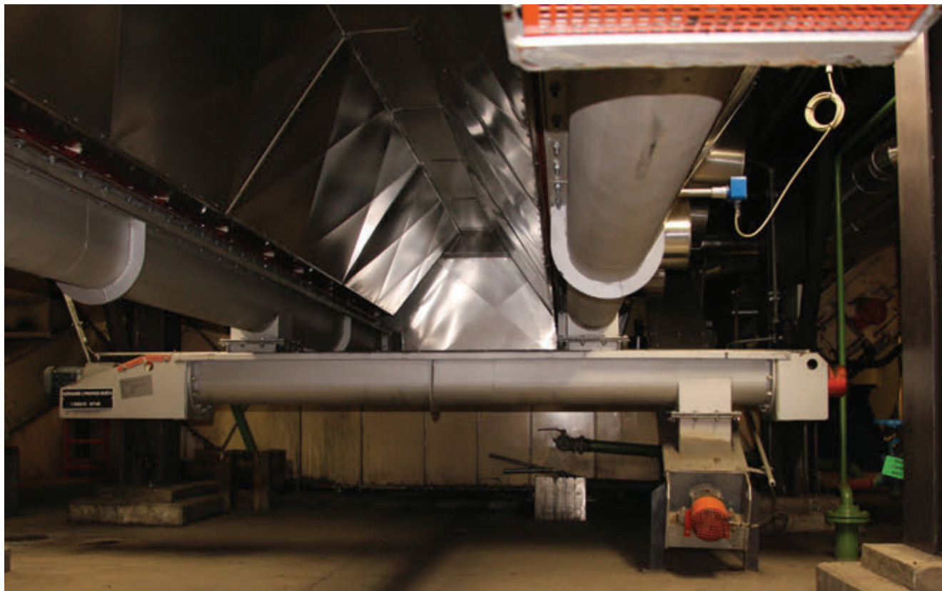
Soustava šneků pro vynášení škváry pod roštem
