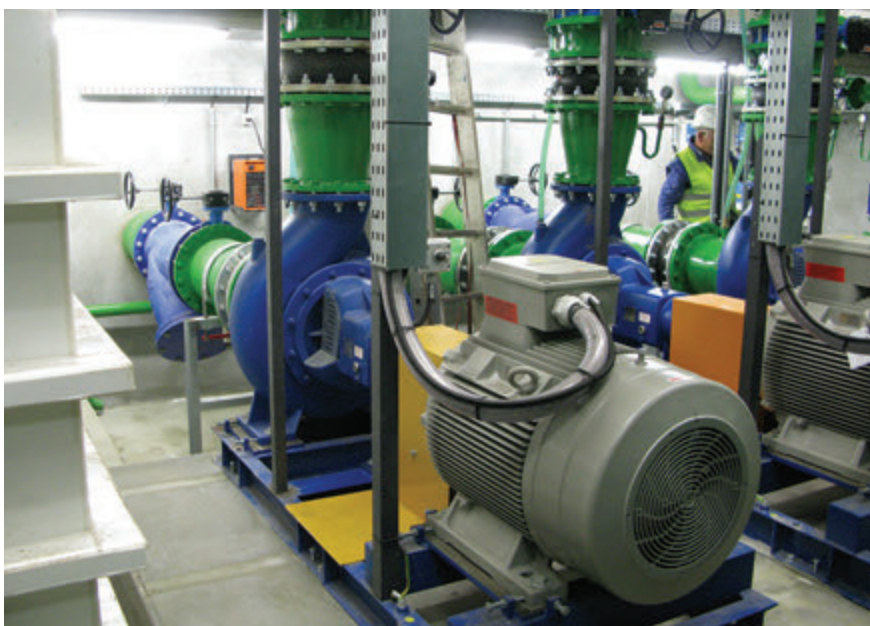
Čerpadla v čerpací stanici
