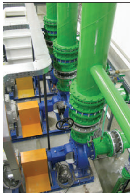
Pohled do čerpací stanice
