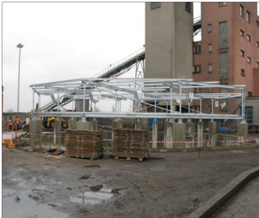
Zahájení montáže ocelových konstrukcí věže
