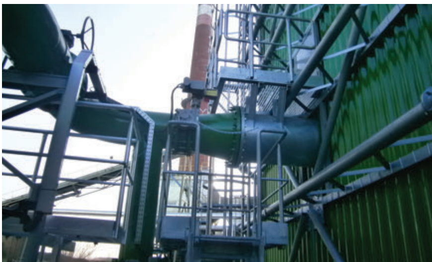
Propojovací potrubí mezi věží a čerpací stanici
