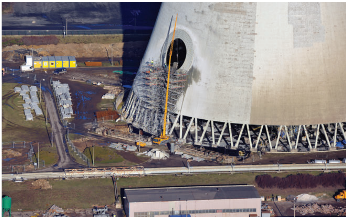
Prostup ve věži pro kouřovod čistých spalin
