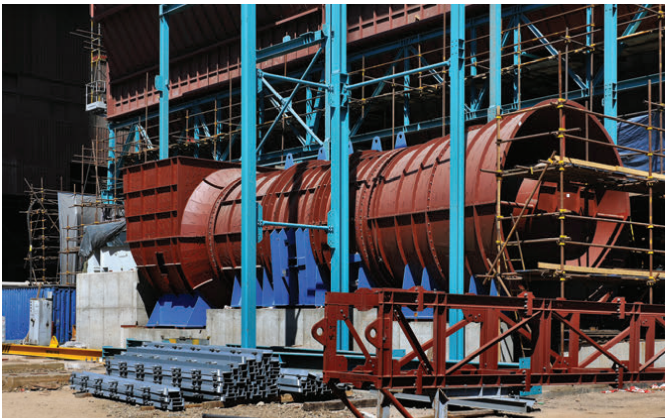
Montáž kouřového ventilátoru
