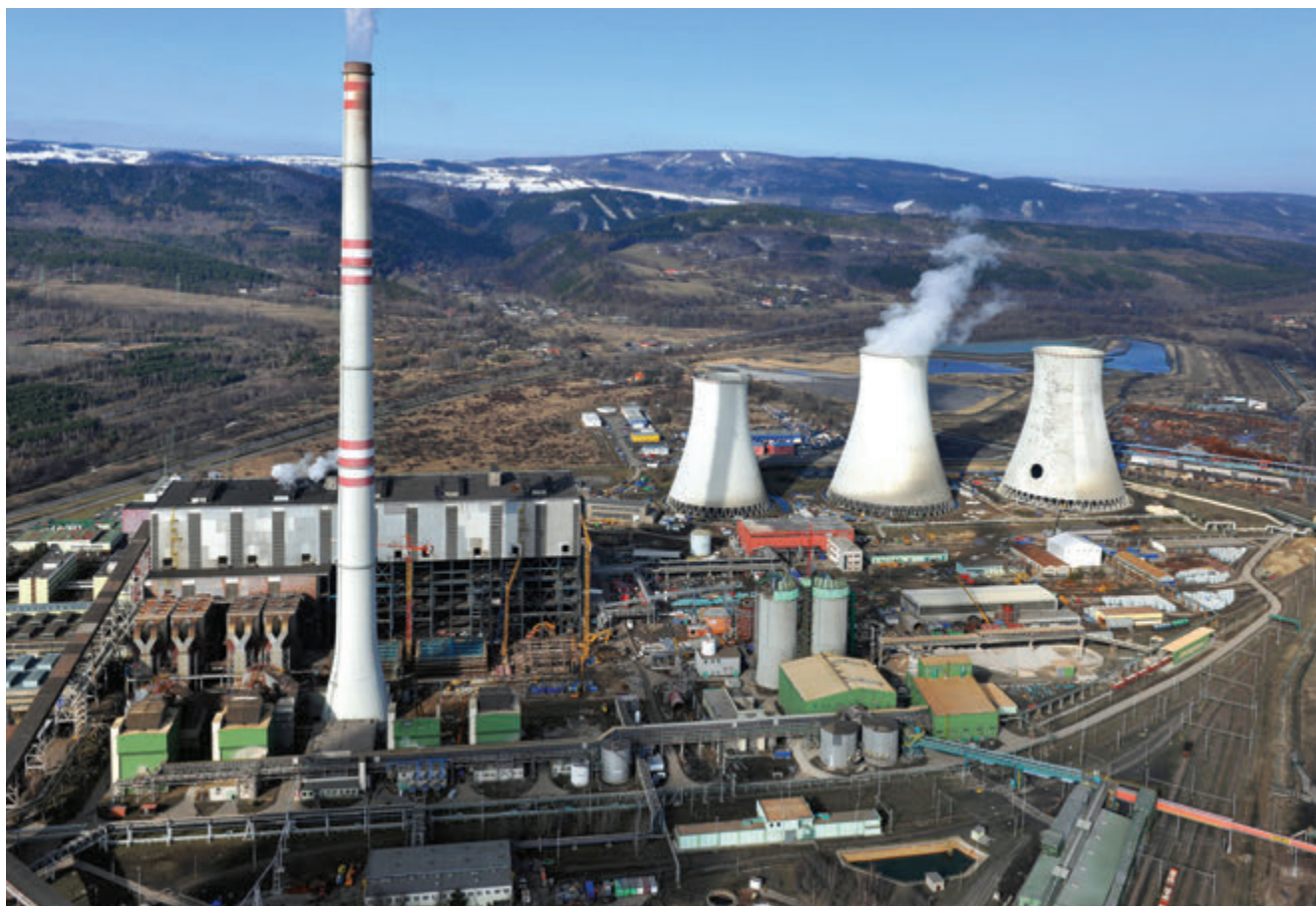
Celkový pohled na elektrárnu Pruněřov
