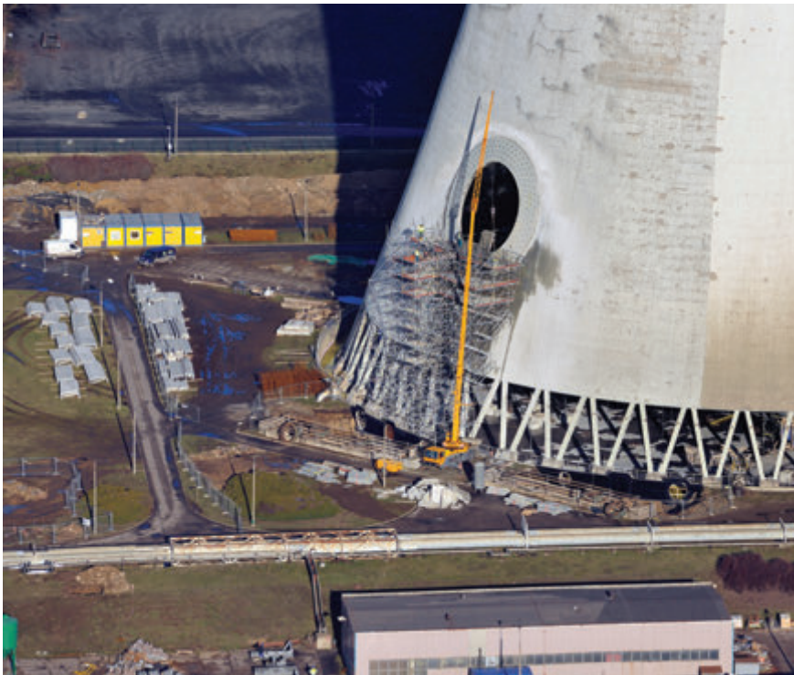
Prostup ve věži pro kouřovod čistých spalín
