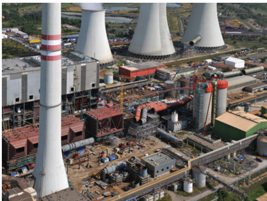
Partie za kotli a odsíření
