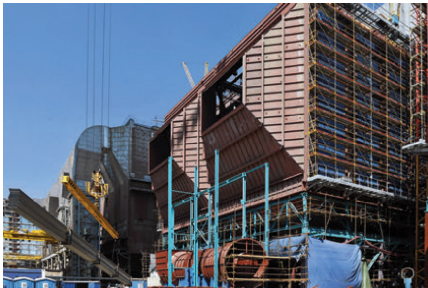
Montážní práce na elektroodlučovačích
