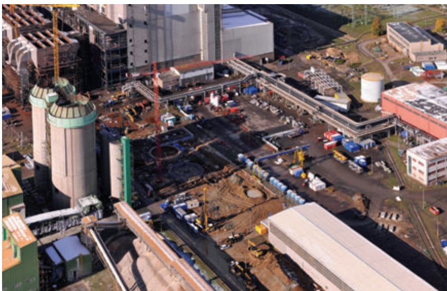
Výstavba nového odsíření
