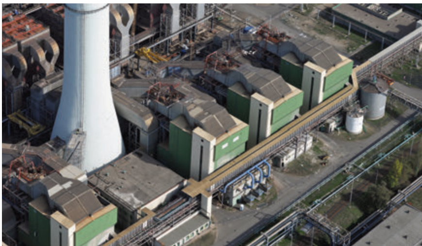
Původní absorbér odsíření
