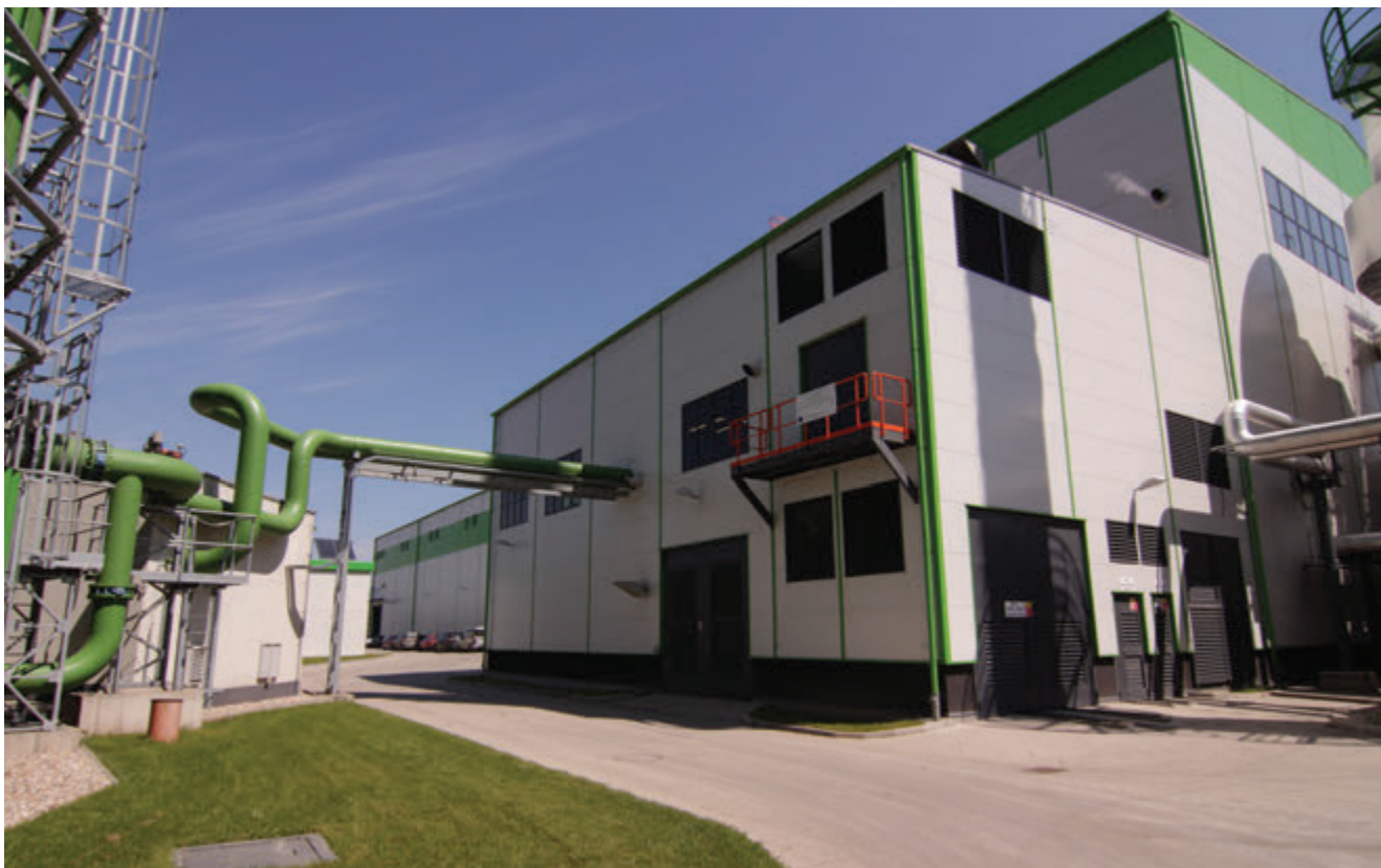
Pohled na turbinovou halu
