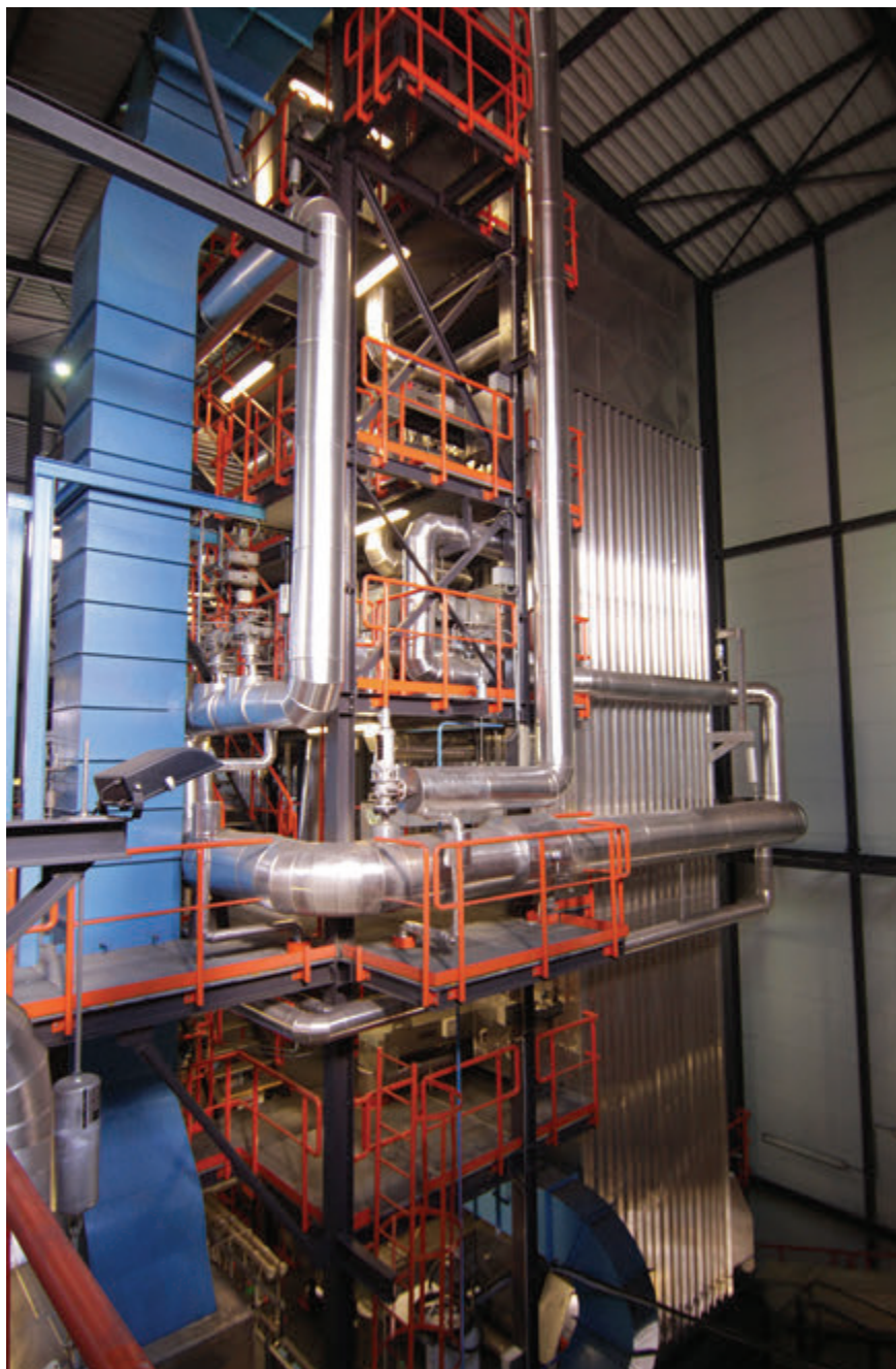
Pohled na kotel - zadní sekce s ekonomizérem
