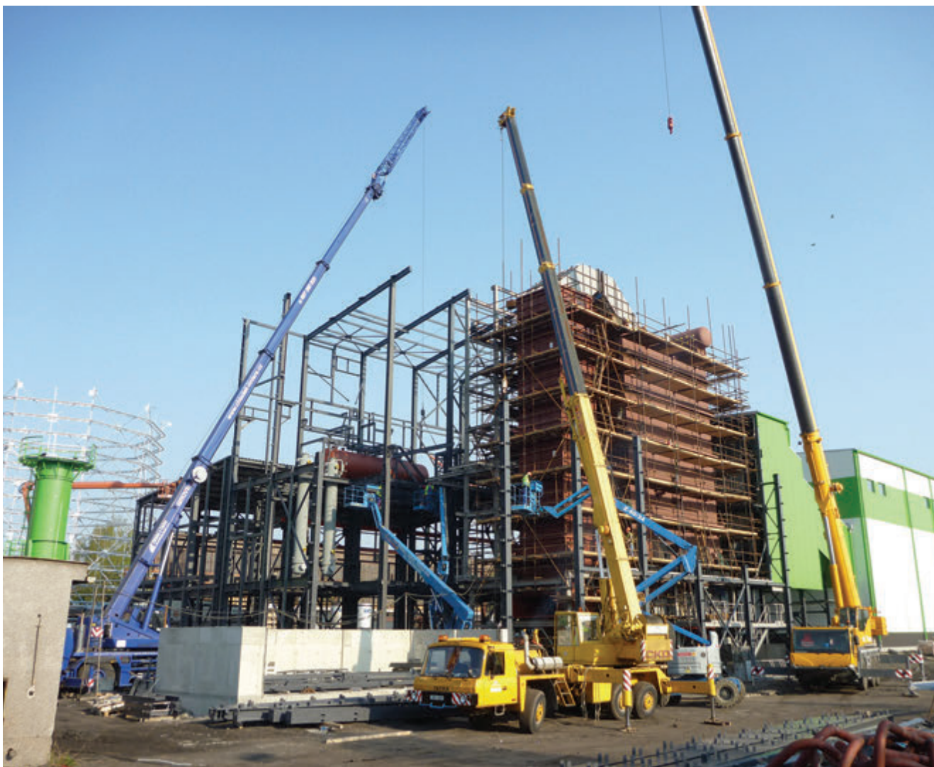
Budova tepelné strojovny a kotleny rostla společně s kotlem (červen 2011)
