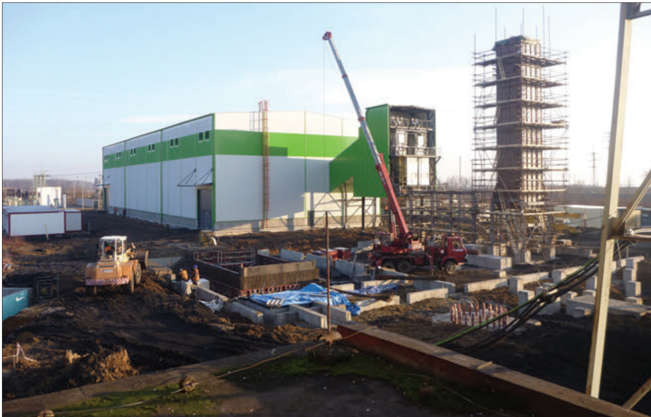
Výstavba bioelektrárny v lednu 2011
