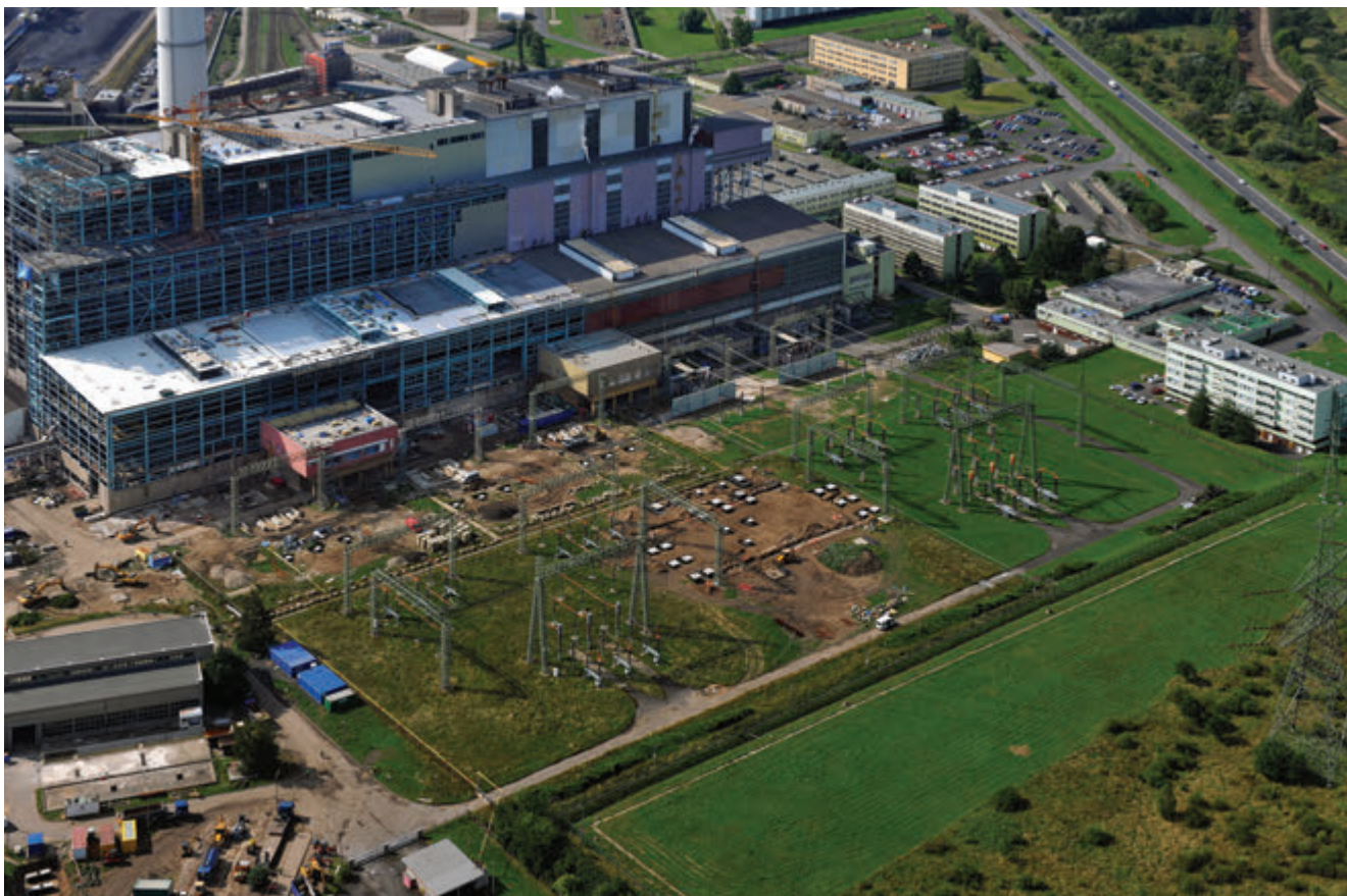
Realizace opláštění severní stěny
