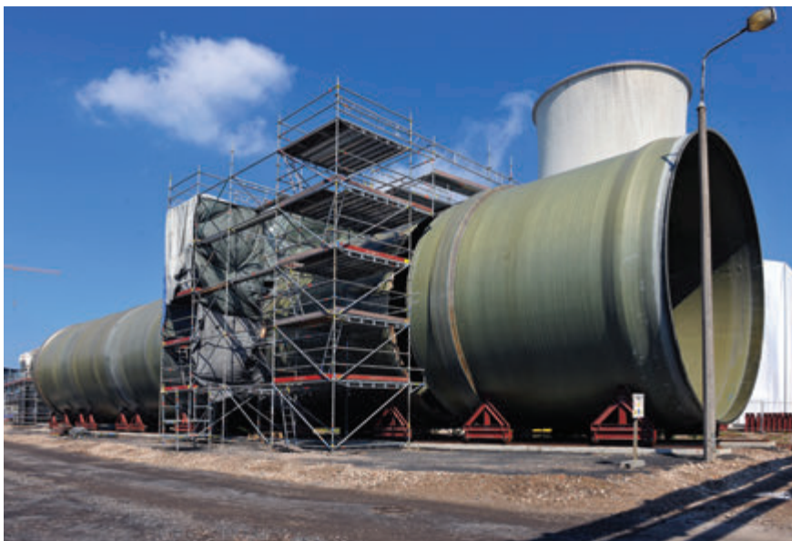
Předmontáž kouřovodu čistých spalín
