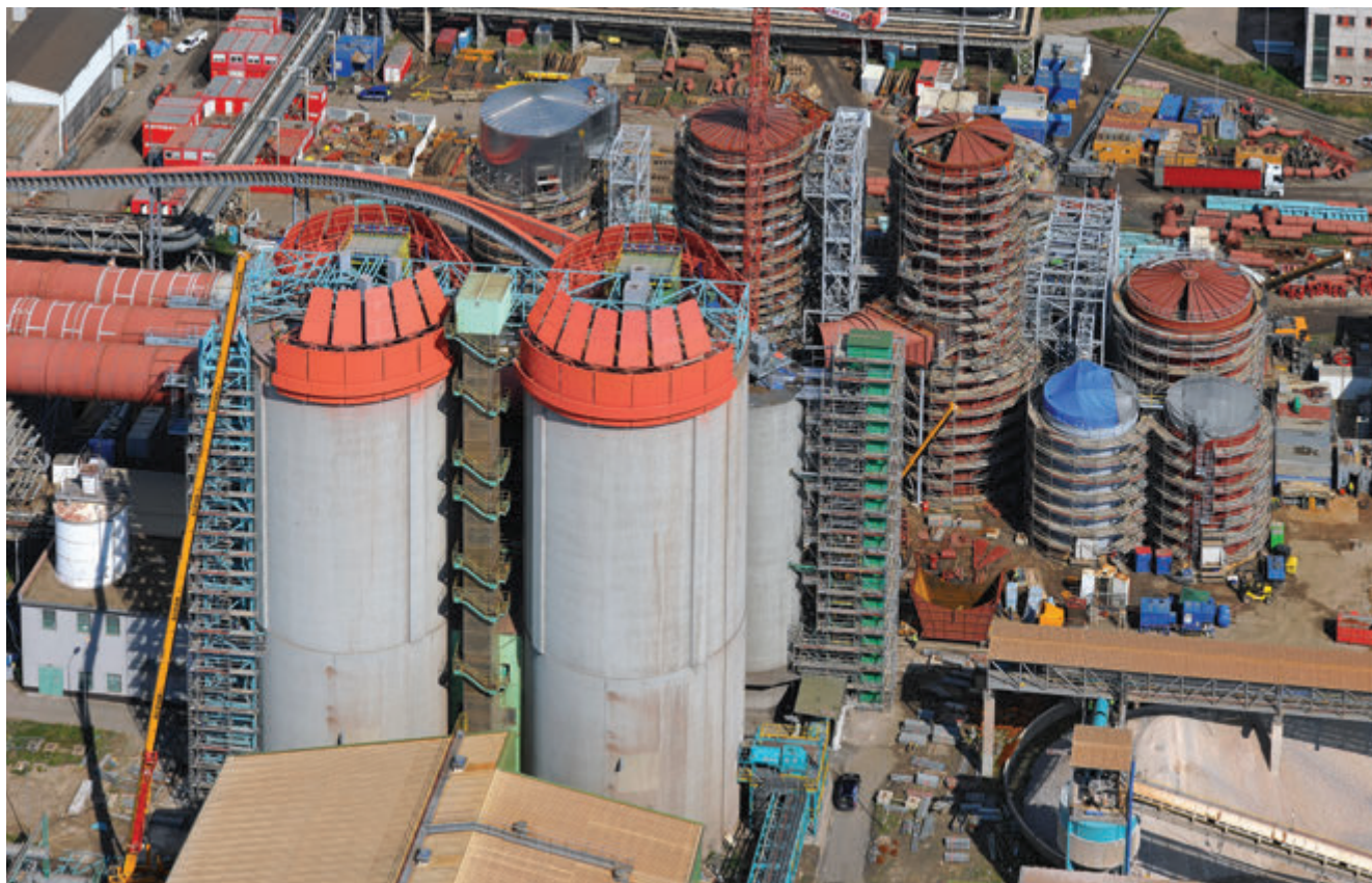
Výstavba nového odsiřování
