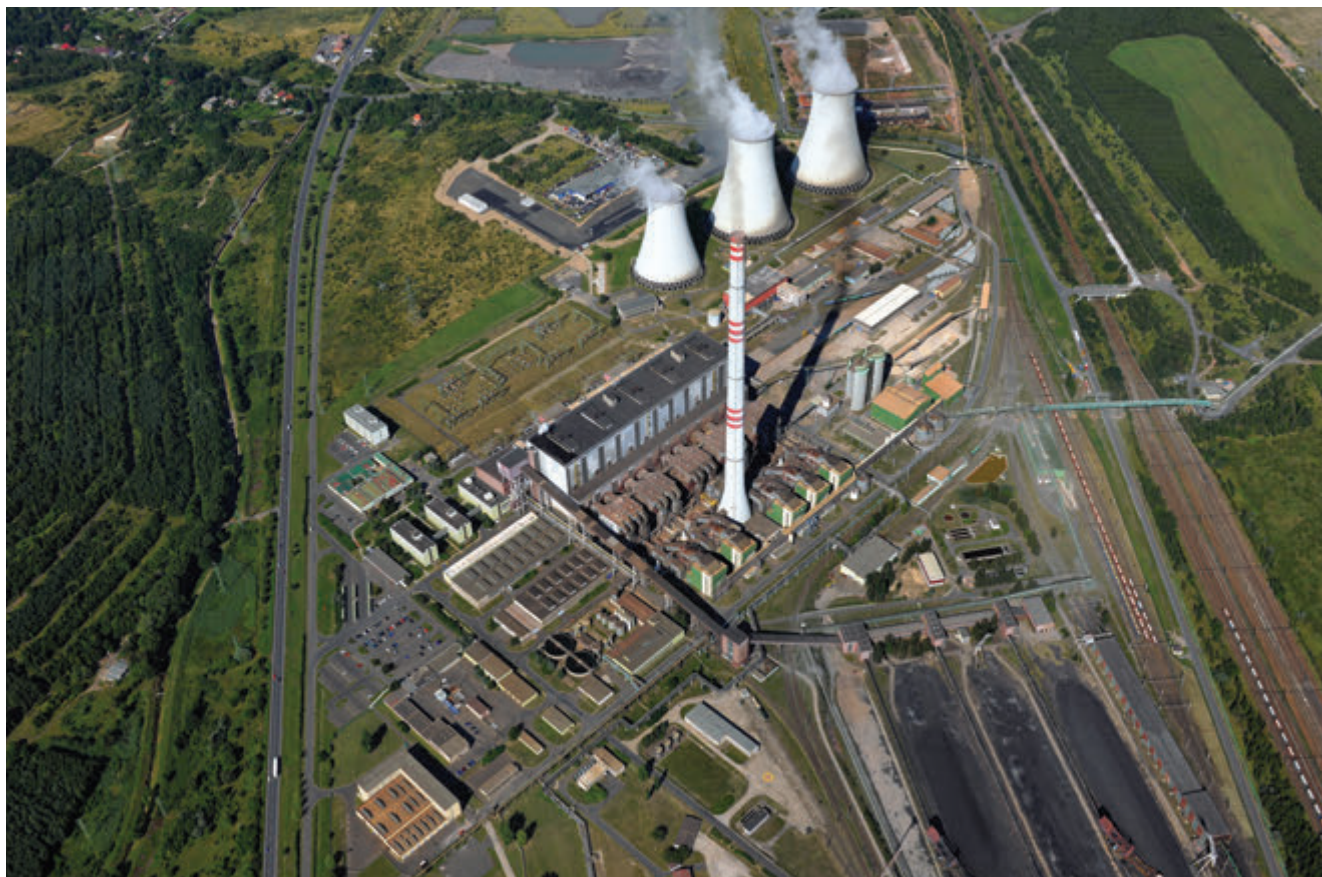
Celkový pohled na Elektrárnu Prunéřov II
