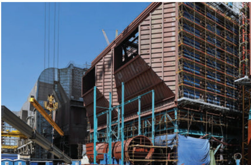
Montážní práce na elektroodlučovačích
