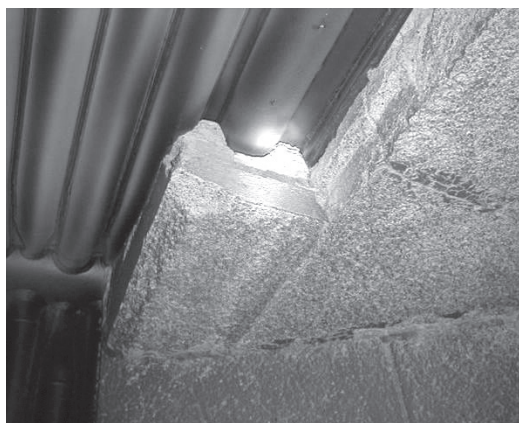
Detail po provedené opravě vyzdívek Spalovací komory
