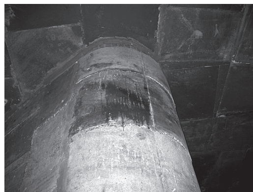
Pohled na dokončenou část nové vyzdívky Nosu
