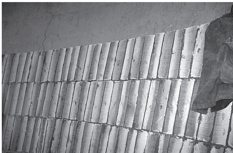
Instalace nové vyzdívky izolační vrstvy
