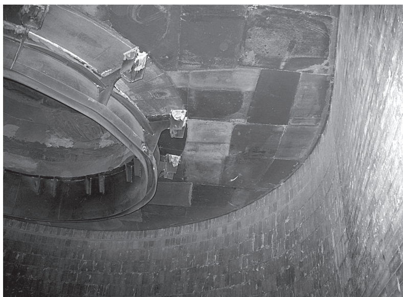
Pohled na novou vyzdívku Cyklonu
