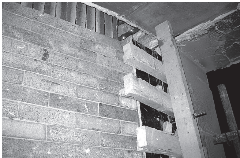
Pohled na novou dokončenou vyzdívkou z andaluzitového tvarového materiálu
