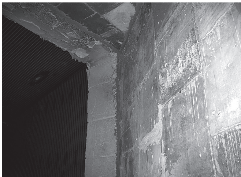
Pohled na dokončenou část nové vyzdívky Vstupního spalínovodu
