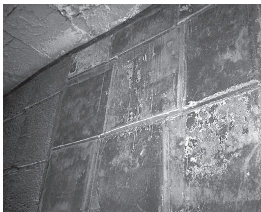
Pohled na dokončenou část nové vyzdívky ze žárobetonu
