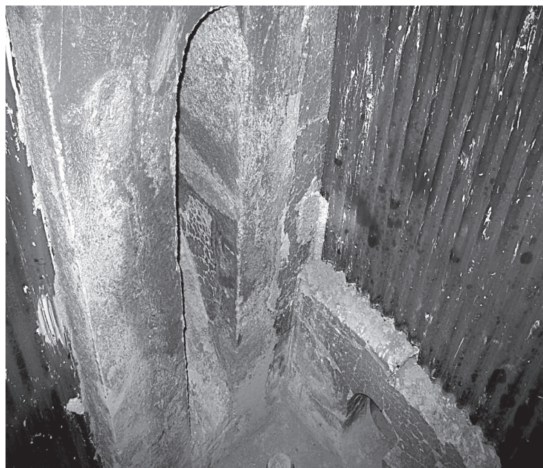
Pohled na stav ocelové konstrukce po demontáži vyzdívek
